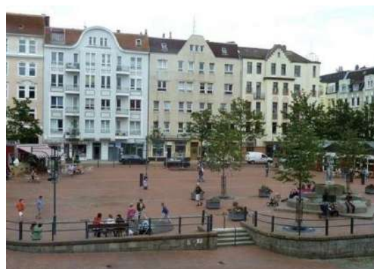
(B) Façade avant rénovation, Kiel
