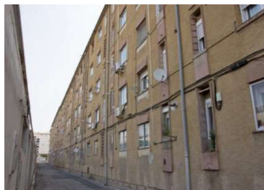
(B) Façade avant rénovation
