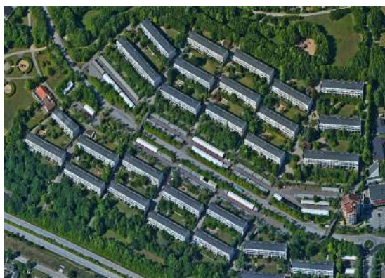
(A) Vue aérienne, Linero (Suède)
