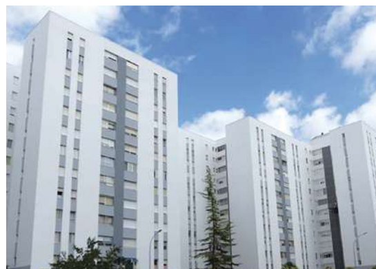
(B) Façade après rénovation, Laguna de Duero (Espagne)
