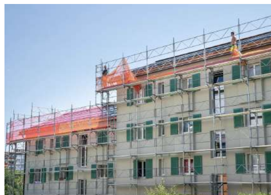
(B) Façade avant rénovation
