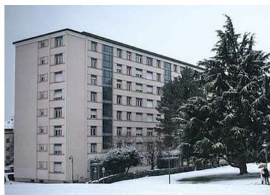
(B) Façade avant rénovation
