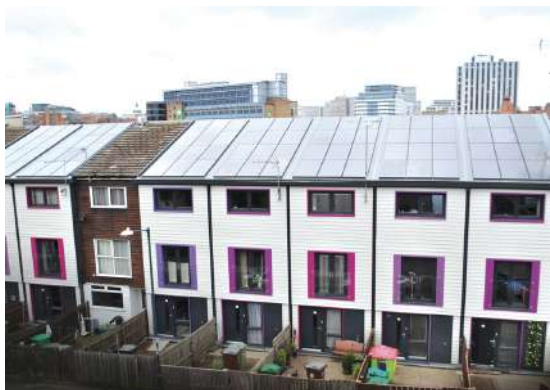
(A) Immeubles après rénovation
