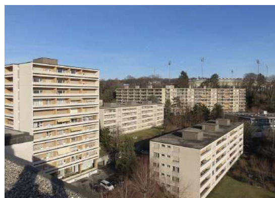
(B) Façade avant rénovation
