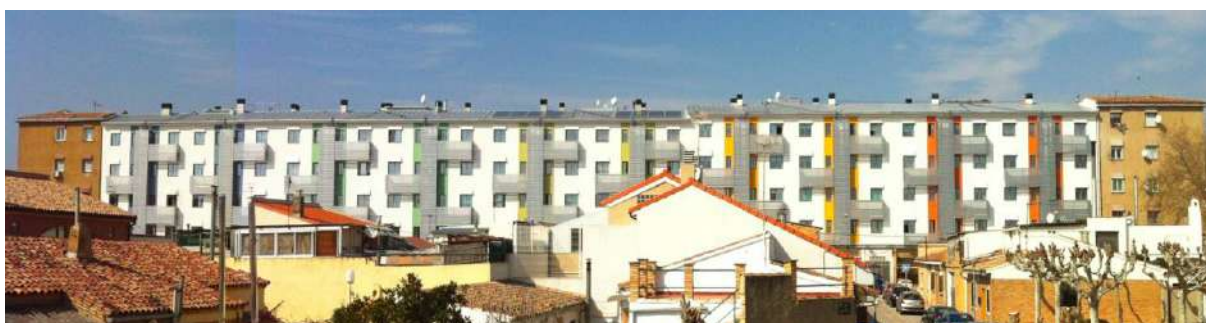
FIGURE 6.17 Bâtiments après rénovation
