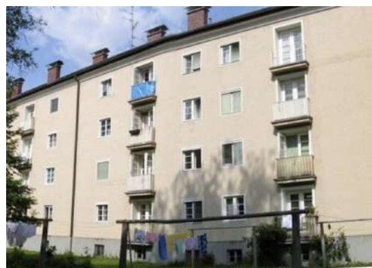
(B) Façade avant rénovation
