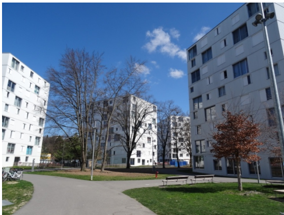
Vue sur les immeubles de la Fontenette depuis les espaces verts extérieurs.
