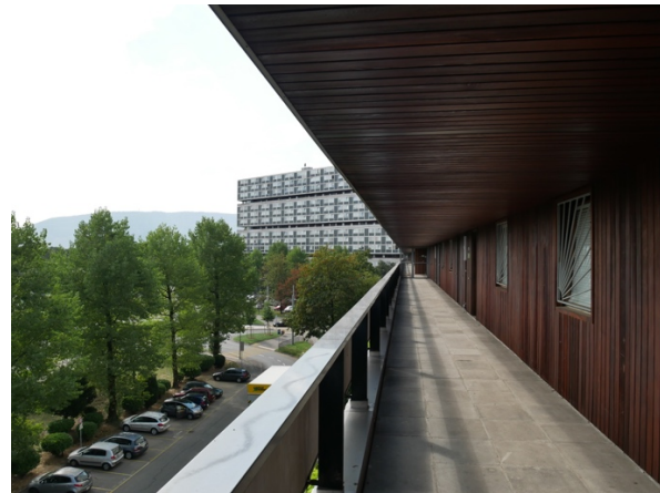
Vue d'une des coursives qui permettait de relier toutes les entrées de la cité : des grilles ont été installées pour limiter les déplacements.
