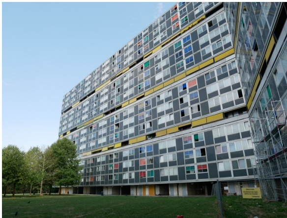
Vue sur les immeubles du Lignon depuis l'espace central de la cité qui offre des espaces verts.
