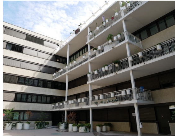
Vue de la cour intérieure et sur les coursives partagées qui la surplombe.
