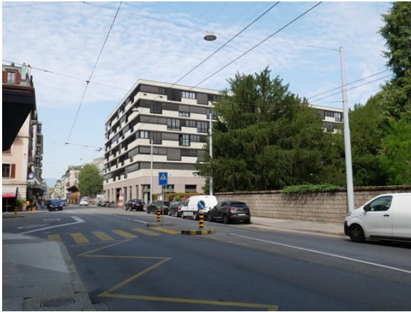
L'immeuble du 23-Août vu depuis le Boulevard Saint-Georges.
