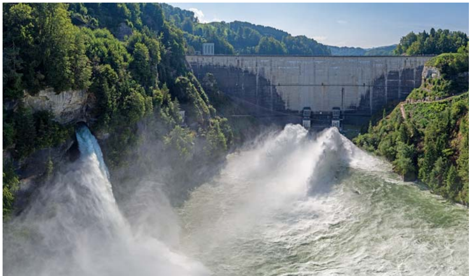
Bild 3. Künstliches Hochwasser an der Saane unterhalb der Staumauer Rossens vom 14. und 15. September 2016. Bild: Forschungsgruppe Ökohydrologie ZHAW.
