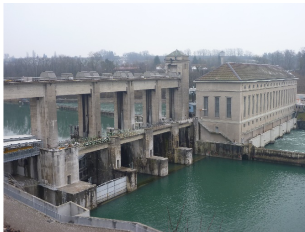
Figure 1 : Vue de l'aménagement de la rive droite (France) : barrage au premier-plan et usine à l'arrière-plan.
