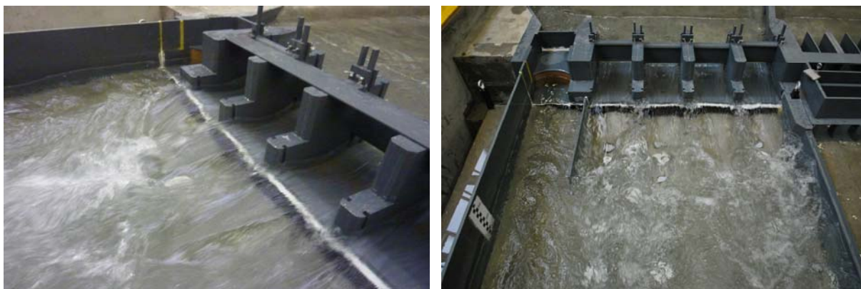
(a) Sans mur anti-courant de retour (b) Avec mur anti-courant de retour Figure 3 : Photo de la recirculation avec et sans le mur anti-courant de retour pour Q = 1575 \text{ m}^3/\text{s} .
