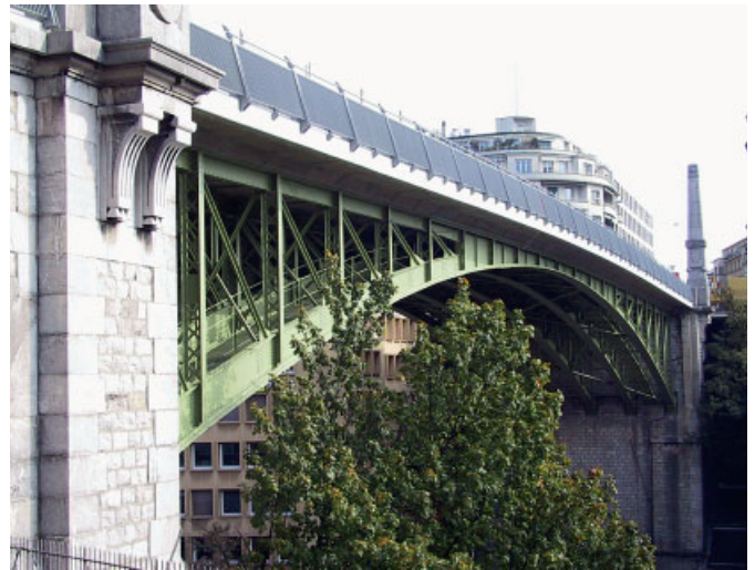
Bild 9. Bessières Brücke in Lausanne nach der Instandsetzung
