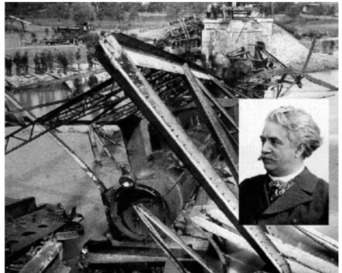
Bild 1. Einsturz der Bahnbrücke über die Birs bei Münchenstein bei Basel am 14. Juni 1891 (Porträtbild von Prof. Ludwig von Tetmajer, einer der Experten zur Klärung der Unfallursache)
