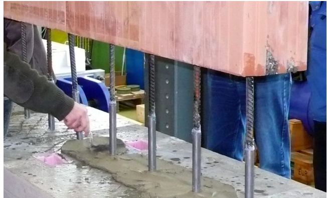
Abb. 3: Anschlussdetail bei der Montage von BMW1
