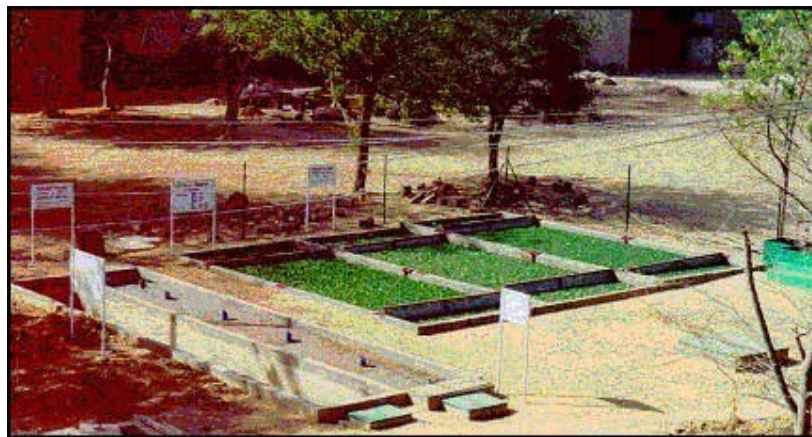
Figure 3.5 : Vue générale des bassins à laitues d'eau de l'EIER
