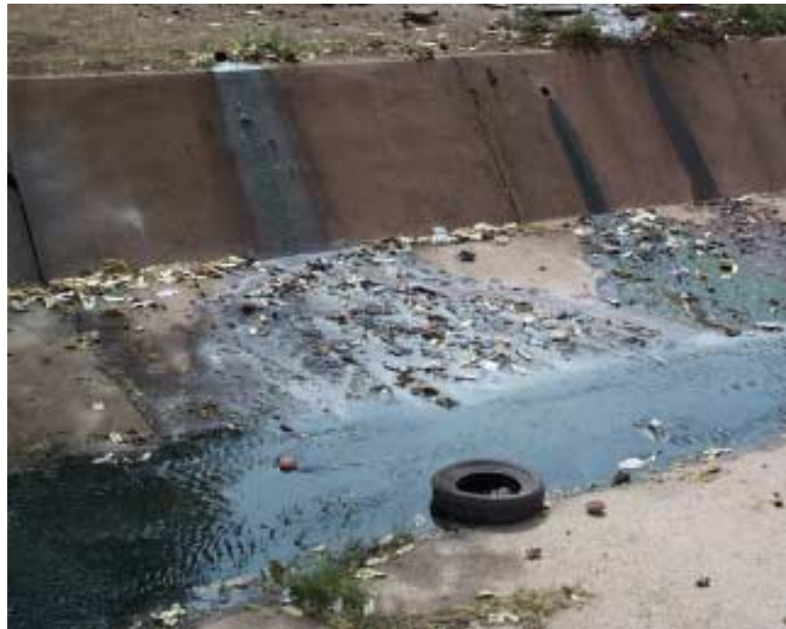
Figure 1.1 : Evacuation des eaux usées du centre ville dans le Canal Central de Ouagadougou
