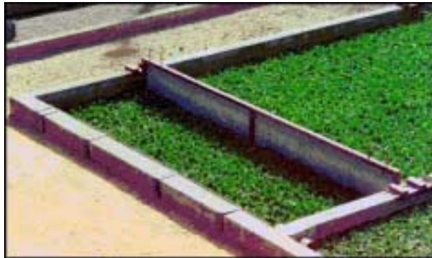
Figure 3.8 : Cloison verticale disposée à 1 m de l'entrée ou de la sortie des bassins
