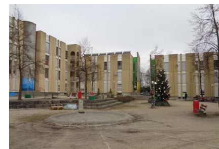
cour centrale - un endroit pour se retrouver quand il ne fait pas trop froid
