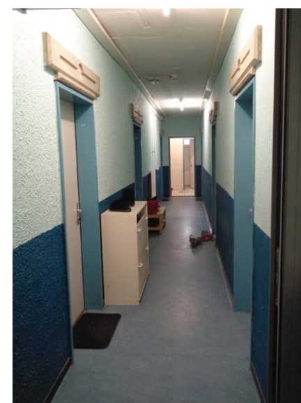
couloir - l'entreposage de meubles y est interdit mais les résidents continuent d'occuper l'espace
