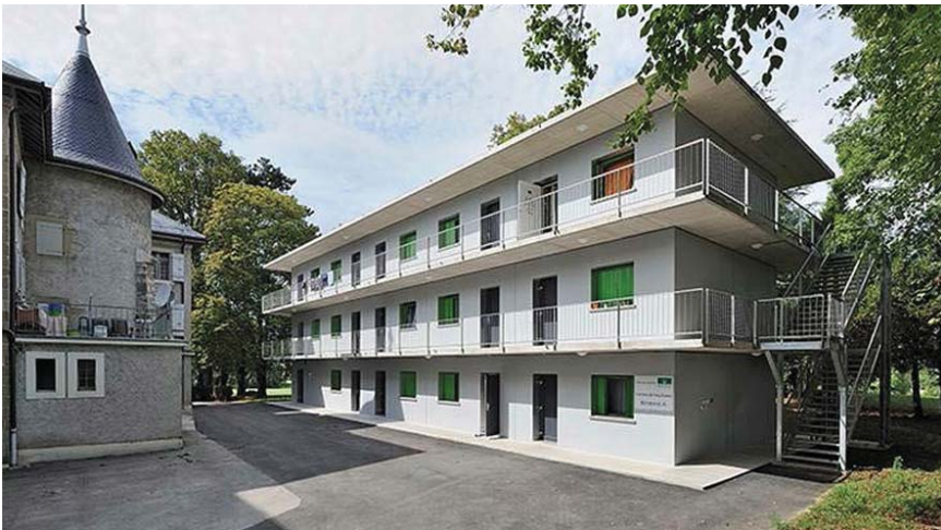
l'arrière du foyer avec l'une des deux nouvelles annexes
