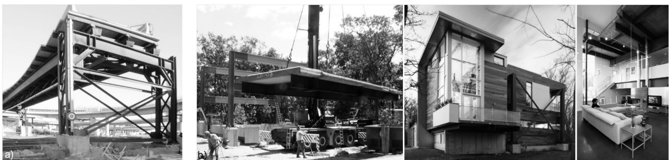
Fig. 5 Reuse of steel and concrete composite slabs from a temporary motorway bridge in Boston, MA (a) to a house in Lexington, MA in 2013 by architecture office Single Speed Design (b) Wiederverwendung von Stahlbetonverbundplatten einer provisorischen Autobahnbrücke in Boston, MA (a) für ein Wohnhaus in Lexington, MA im Jahre 2013 durch das Architekturbüro Single Speed Design (b)
