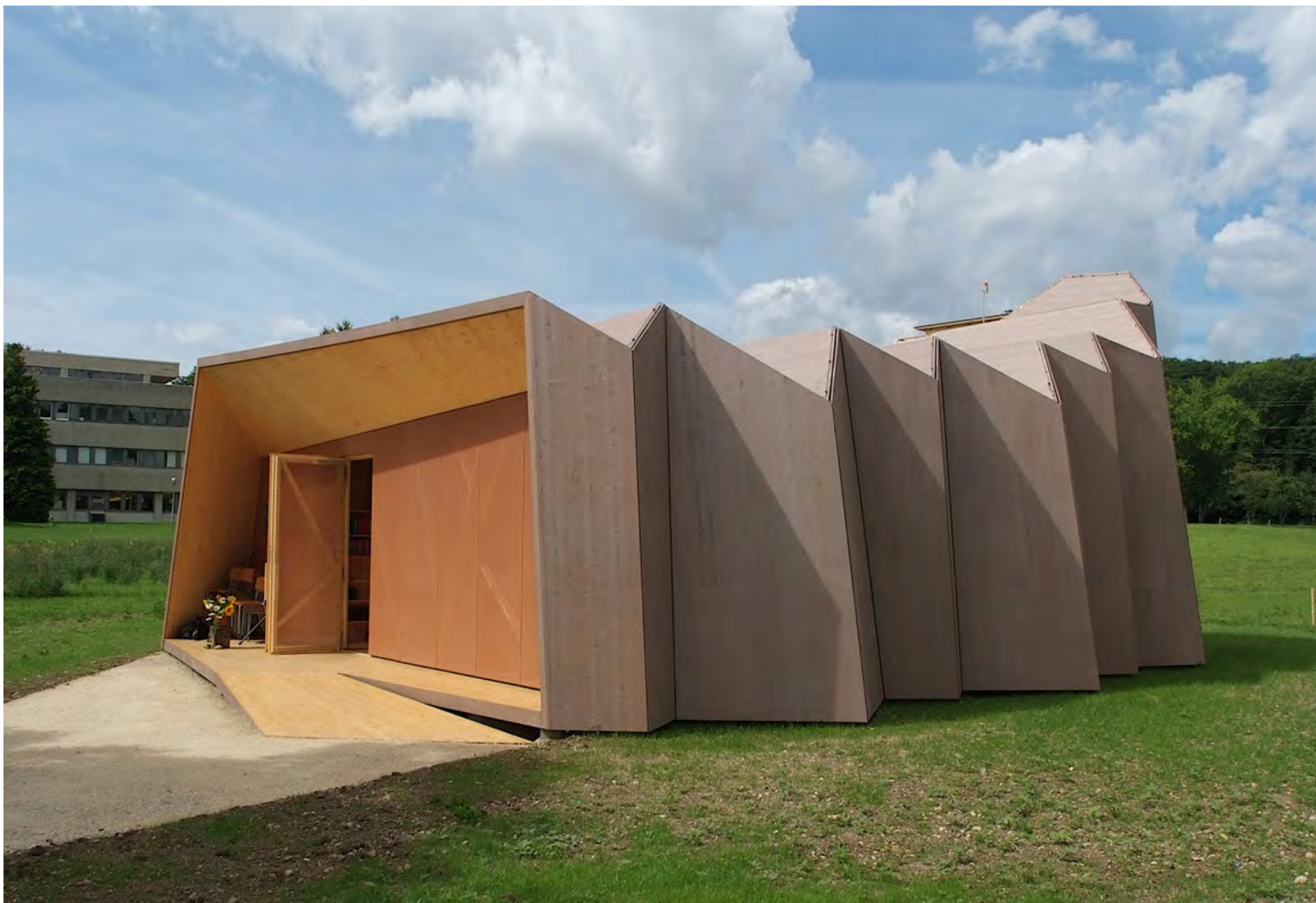
An diesem Projekt waren die Autoren des folgenden Textes maßgeblich beteiligt: Arbeitsgemeinschaft Localarchitecture, Danilo Mondanda und Shel, temporäre Kapelle St. Loup, Pompaples (Schweiz), 2008
