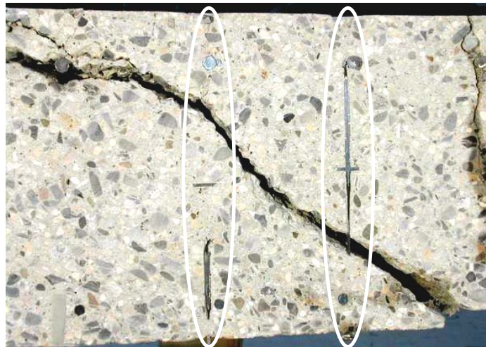
Figure D-3.29: Section de la dalle PG-10 avec détail du dispositif de mesure des fissures internes
