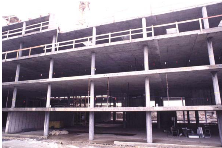
Figure 7.1: Planchers-dalles en phase de construction
