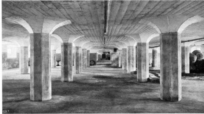
Figure 2.4: Dalle-champignon à la Giesshübelstrasse à Zürich, 1910, ing. Robert Maillart [Maillart26]
