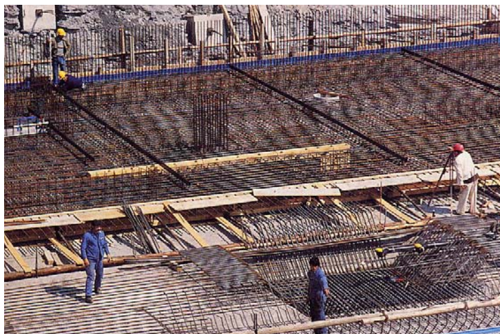
Figure 7.34: Radier de fondation en phase de construction
