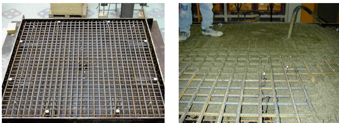
Figure D-2.5: Armature complète et bétonnage de la dalle PG-1
