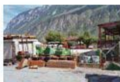
3) Sierre, Îles Falcon : engins de chantier et fûts
