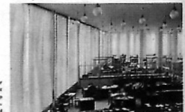
Innen der Büroräume. Der Vorteil der Glaswand wird erst im oberen Stock deutlich, wo trotz beträchtlicher Deckenstärke die Glänge taghell sind.
