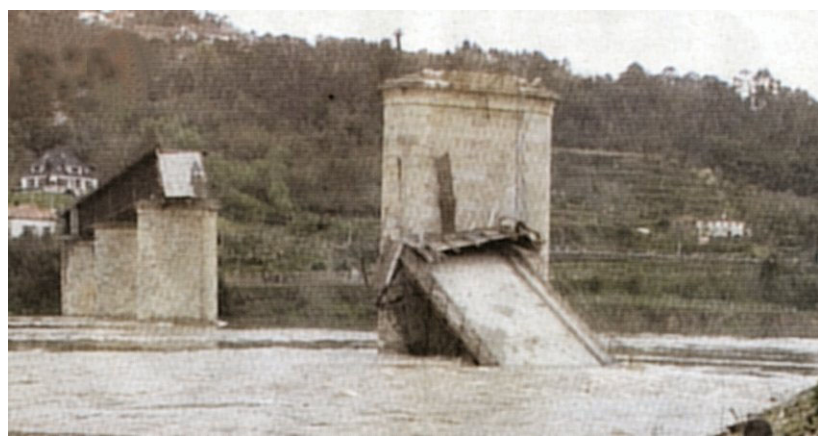
Bild 8: Der Einsturz einer 116 Jahre alten Douro-Brücke nahe Porto in Portugal kostete 80 Menschenleben; Grund: Unterschätzung der Gefahr durch Unterspülung
