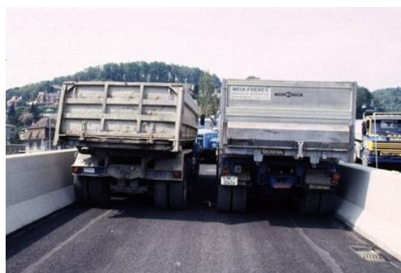
Bild 186: Situationen in denen die Verkehrslasten besser als die Wirkung verteilter (links) oder konzentrierter (rechts) Lasten erfasst wird
