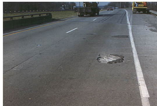
Bild 60: Fahrbahnübergänge und Schlaglöcher als Quellen von starken, lokalen Unebenheiten (Fotos mit freundlicher Genehmigung des IS-Beton, EPFL)
