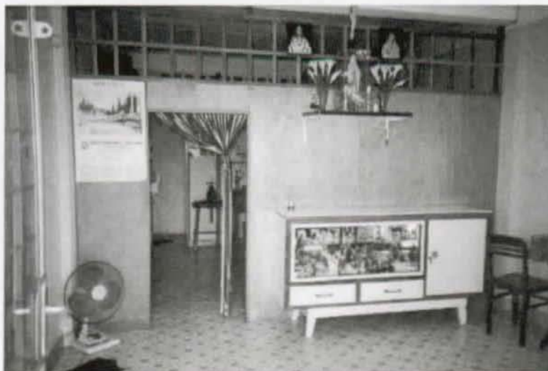
Le cloisonnement horizontal de l'appartement au moyen d'une paroi légère
