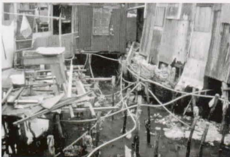
Système complexe et auto-construit d'approvisionnement en eau
