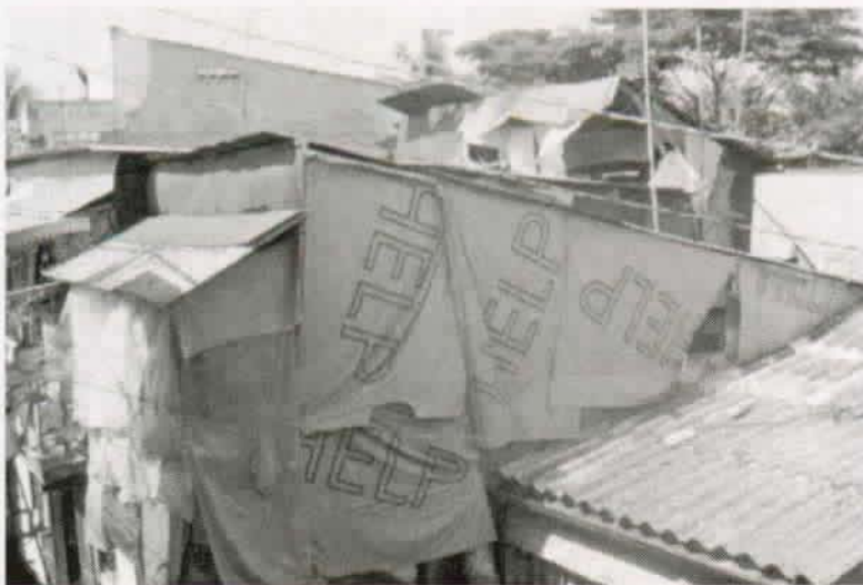
Une utilisation mixte du bois, de la tôle, du plastique et des déchets industriels
