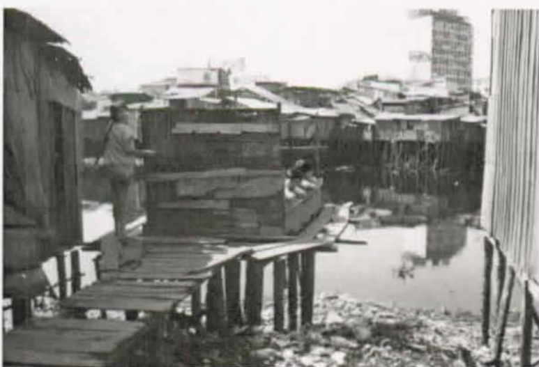
Des toilettes publiques construites directement sur le canal
