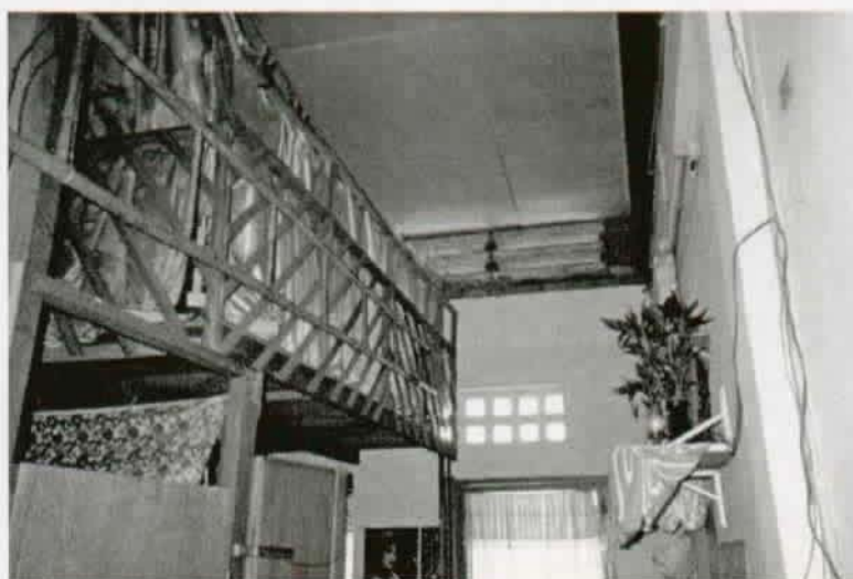
Aménagement d'une mezzanine sous les combles
