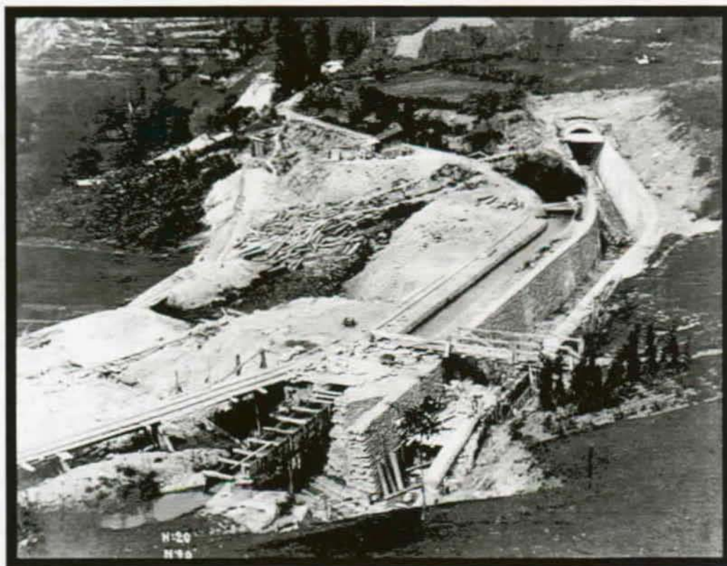
Aymavilles (AO) – infrastruttura a monte della centrale idroelettrica – vista dall'alto, fotografia 1921.
