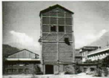
Aosta – Stabilimento Cogne, Fabbricato Trattamenti Termici N.2 [demolito].
