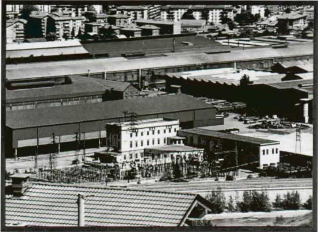
Aosta e la "Cogne" - particolare: vista dalla collina di Charvensod, a sud, verso nord. Al centro la Cabina Collettrice, 1998.
