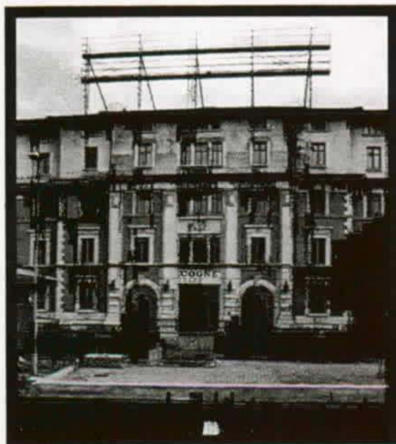
Aosta - stabilimento siderurgico "Cogne": particolare della facciata dell'edificio della Direzione, 1998 c.
