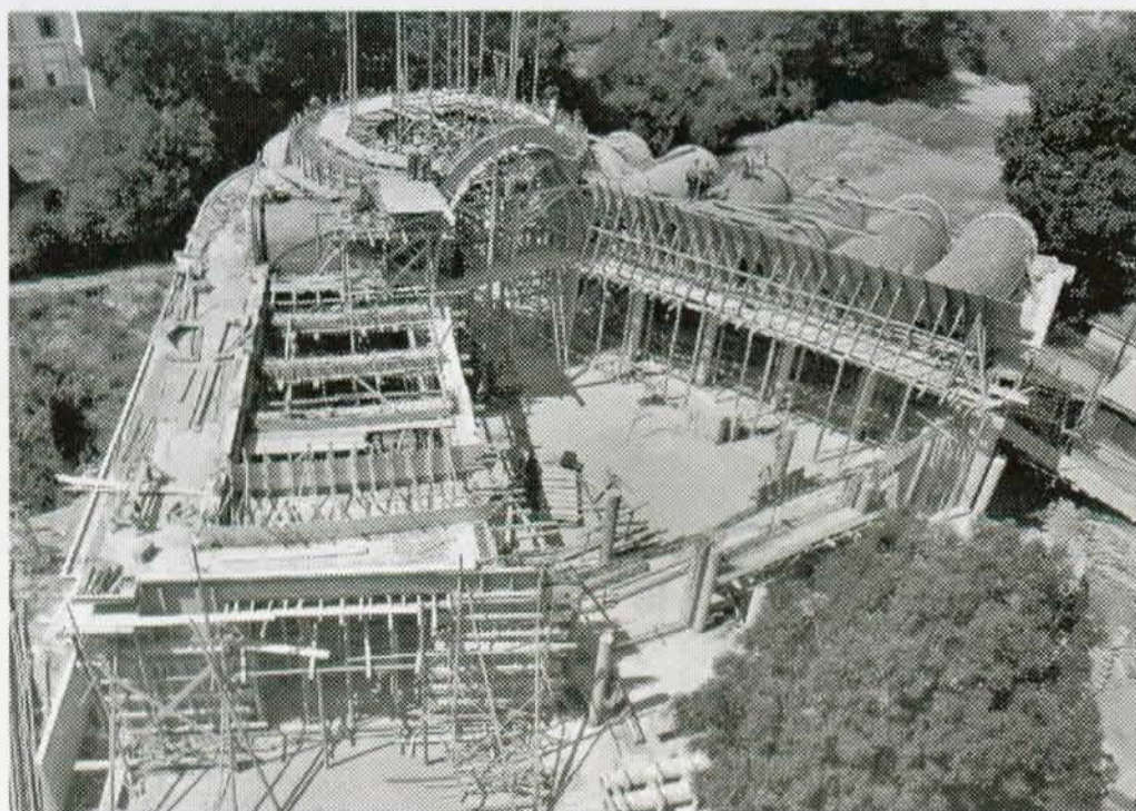
Fig. 35 Construction des voûtes transversales des collatéraux, été 1952.
