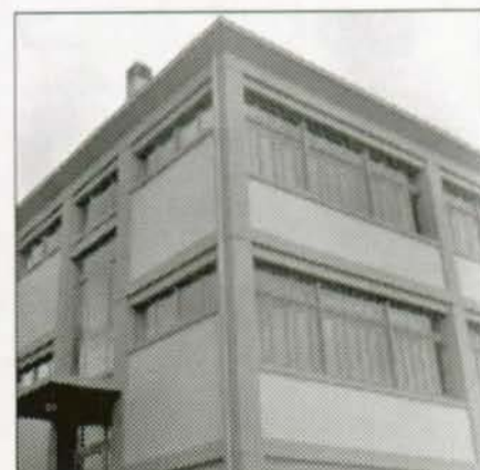
A. Perret: Musée des Travaux publics.
