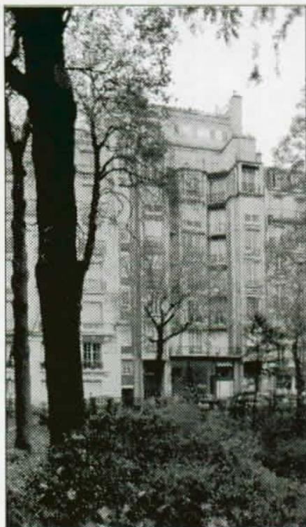
A. Perret, immeuble rue Franklin, Paris.
