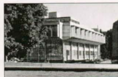
Chaufferie. Immeuble EDF.
