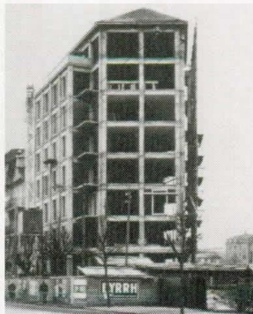
Fig. 29 L'immeuble Pérolles 53, en construction, printemps 1952. – L'ossature attend ses cadres de fenêtres préfabriqués.
