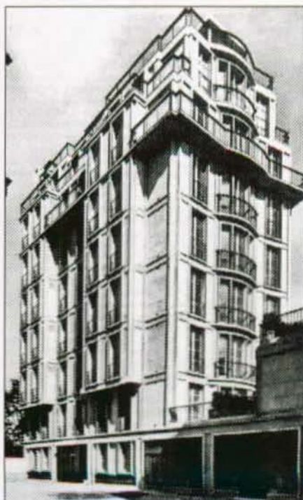
A. Perret: immeuble rue Raynouard, Paris;
