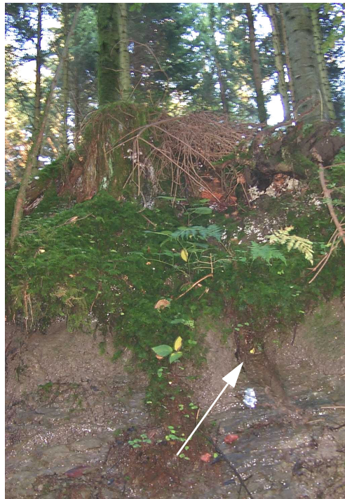
Figure 104. Macropore observé sur la rive droite de la Corbassière à proximité de l'exutoire de Corbamont.
