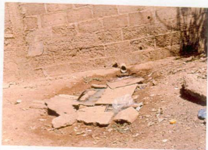
Photo 4.2: Vue d'un exemple de rejets anarchiques d'eaux usées à Ouagadougou.
