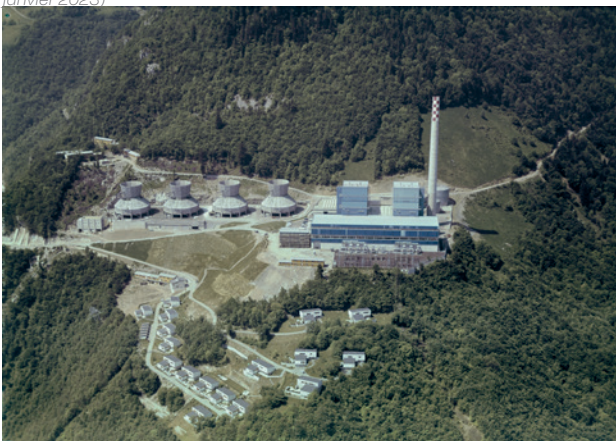
Le site de Chavalon, à gauche les cheminées de refroidissement, à droite la centrale thermique et les maisons des cadres en contrebas. CC-BY-SA 4.0 Swissair Photo AG/ETH-Bibliothek Zürich, Bildarchiv/Stiftung Luftbild Schweiz, http://doi.org/10.3932/ethz-a-000371467 (consulté le 14 janvier 2023)
