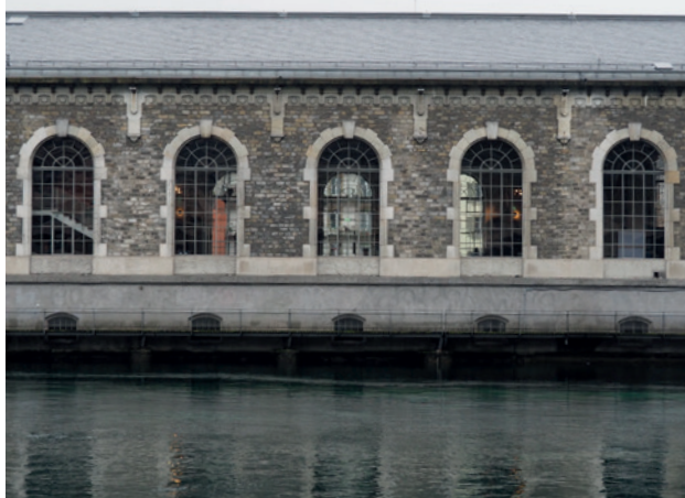
La grande halle des turbines du Bâtiment des Forces Motrices
