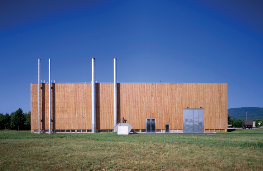
Chaufferie de Bière (VD) , Pierre Bonnet et Bridel Architectes, 1999.
