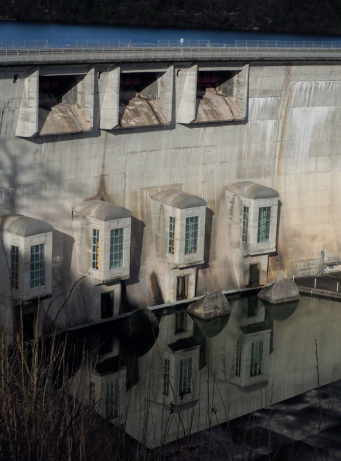
Le barrage de Schiffenen (FR) illustre le gigantisme des installations hydroélectriques d'après-guerre. 1964.
