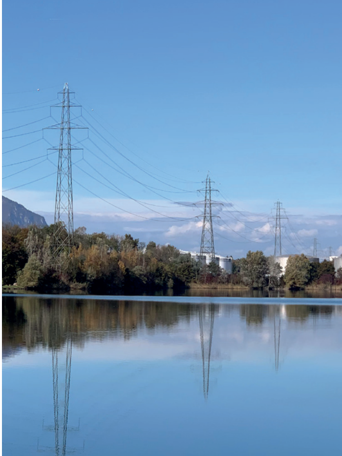
Le paysage de l'énergie dans le Chablais, entre lignes à haute tension et réservoirs à hydrocarbures.
