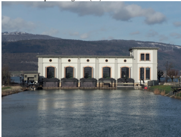
L'usine électrique de Hagneck (BE) au bord du lac de Bielle. 1900.
