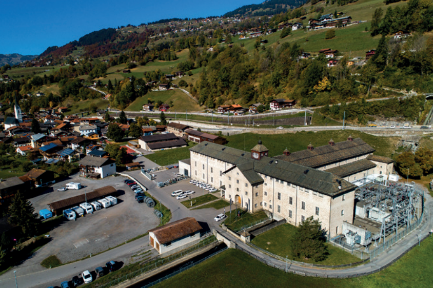
L'usine hydroélectrique de Küblis (GR) en pied de vallée. Nicolaus Hartmann, 1922. CC BY-SA 4.0 Repower AG, https://www.wiki/6Dt9 (consulté le 14 janvier 2023)
