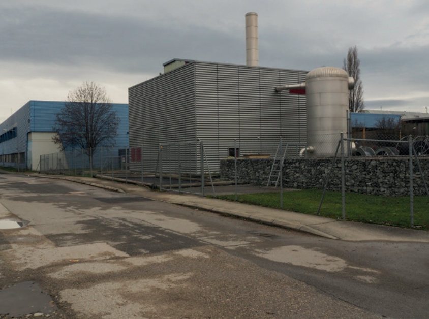
Le bâtiment de la chaufferie de Malley , qui valorise les boues de la STEP.
