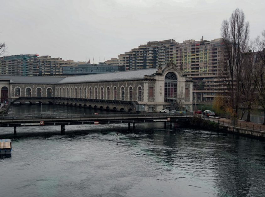
Le Bâtiment des Forces motrices à Genève ou l'ancienne usine électrique de la Coulouvrenière. Théodore Turrettini, 1886.
