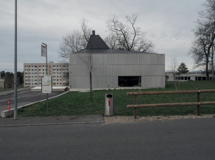
La centrale de chauffage à distance d'Orbe (VD) dévoile ses machines grâce à la grande baie vitrée côté rue. MAK architecture, 2019.
