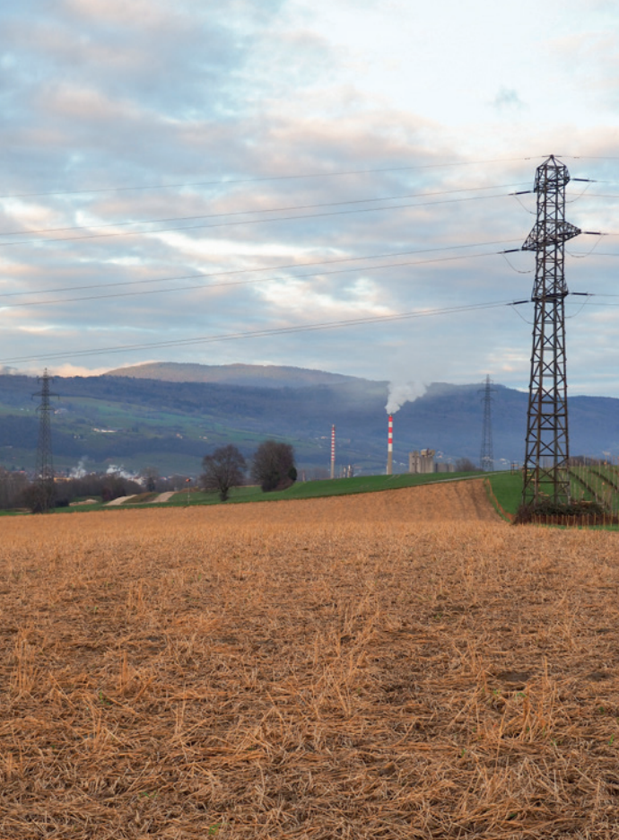
L'infrastructure énergétique imposante de la campagne de la Thielle (NE).
