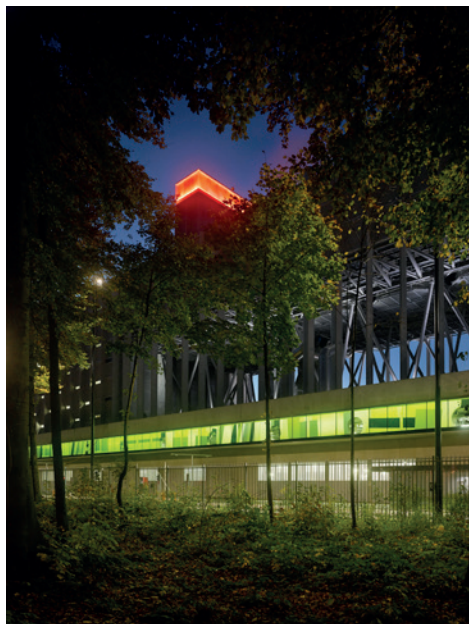
Centrale énergétique Forsthaus, Berne. Graber Pulver Architekten, 2013.
