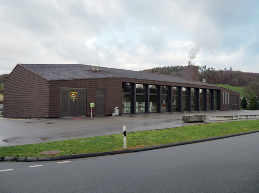
Salle polyvalente de Léchelles (FR) avec locaux pour les sapeurs-pompiers (à gauche) et pour la chaufferie du CAD (à droite). Joud Vergély Beaudoin, 2017.
