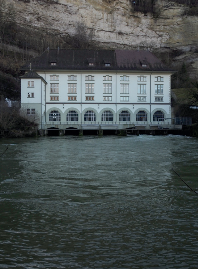
L'usine hydroélectrique de l'Oelberg dans la basse-ville de Fribourg, en lien avec le barrage de la Maigrauge en amont.
