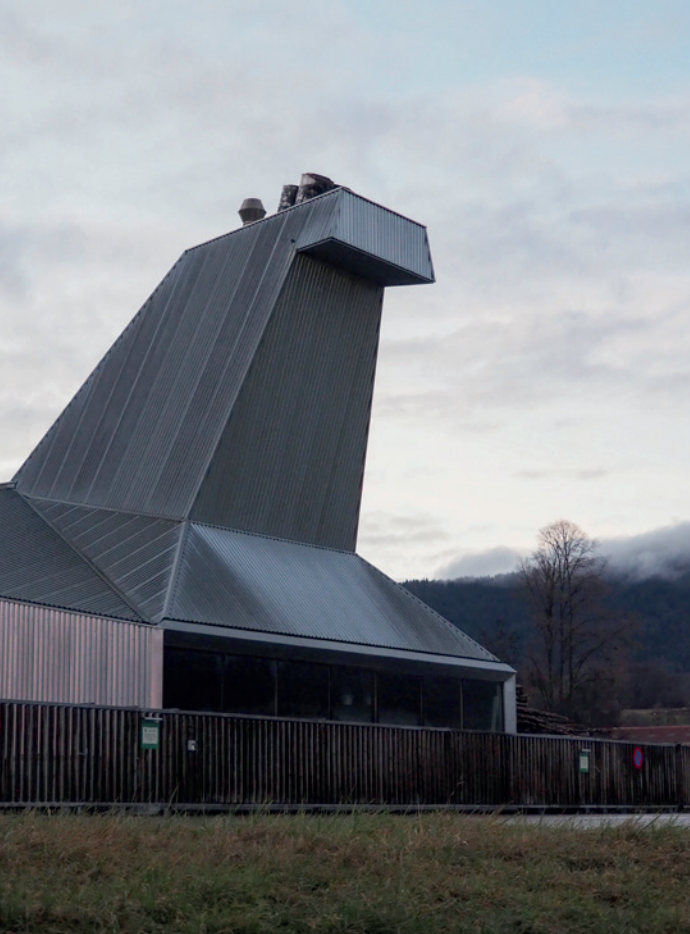
La cheminée de la chaufferie de Lignières (NE) , inspirée d'éléments d'architecture vernaculaire rurale. Repele architectes, 2009
