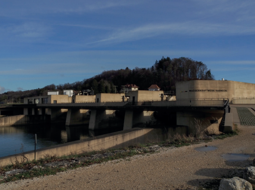
Le nouveau barrage hydroélectrique de Hagneck (BE). Un pont pour piétons et cyclistes longe l'installation et permet de voir l'intérieur de la salle des machines. Penzel Valier, 2015.
