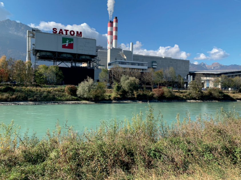
L'usine d'incinération des ordures ménagères de Monthey (SATOM)
