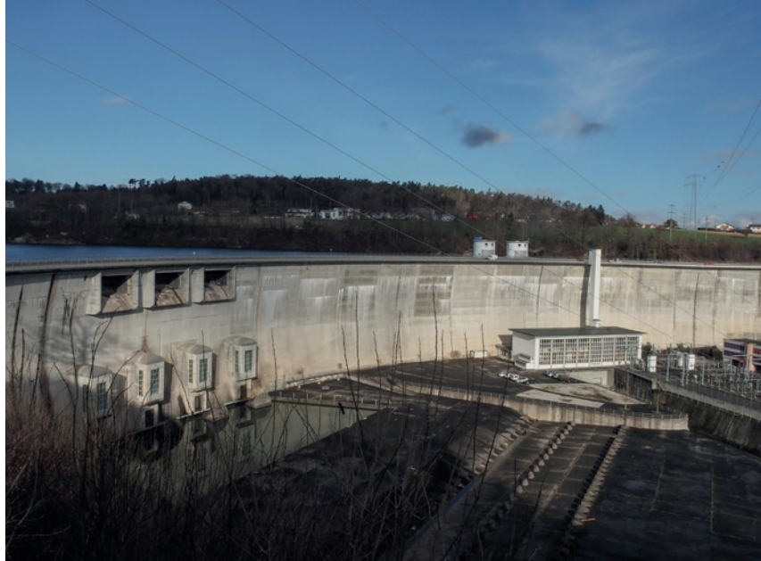
Le barrage intègre la route cantonale
