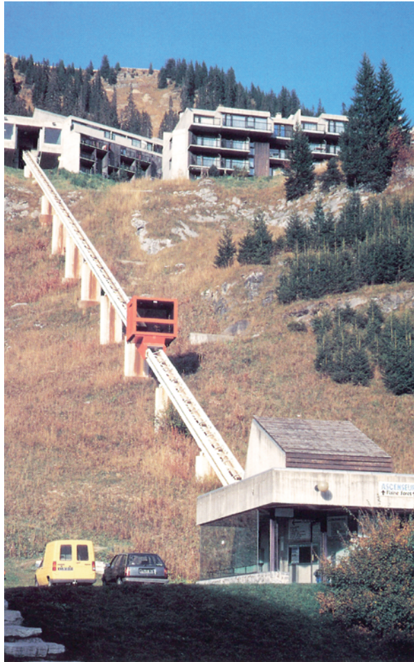
Figure 25 : Dispositif technique permettant le déplacement au sein de la station de Flaine.
