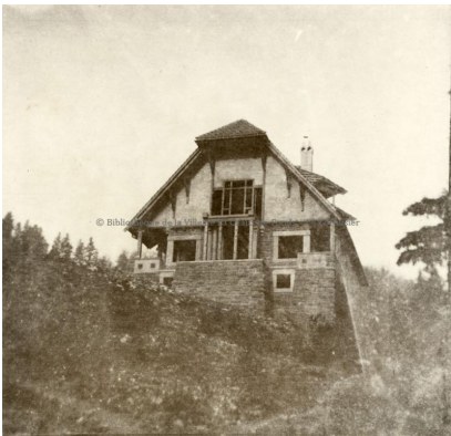
Photographie de la Villa Fallet en construction (BdV, LC108.0734.002)
