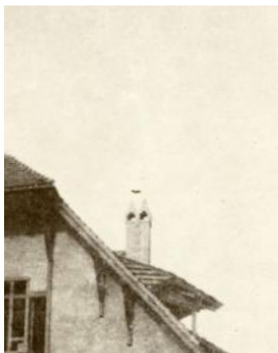
Photographie du détail de la cheminée, 1906 (BdV, LC.108.0734.02)
