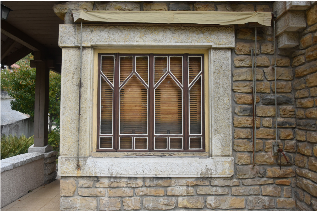
Photographie de la fenêtre Sud-Ouest de salon, avec store à lame en bois et store à projection en toile
