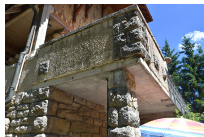
Photographie du détail de l'extension de la terrasse à l'Ouest
