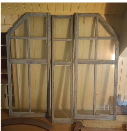
Photographies de la fenêtre du hall d'escalier actuelle et d'une ancienne fenêtre, entreposée dans le grenier
