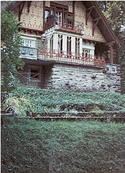
Photographie de la Villa Fallet, vers 1987 (Journal de la Construction de la Suisse Romande, Vol. 61 - 1 er juin 1987 - N° 11, p. 9)
