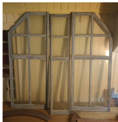
Photographie d'une ancienne fenêtre du hall d'escalier, entreposée dans le grenier
