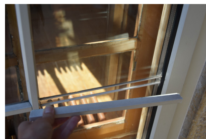
Photographie des menuiseries extérieures de la véranda
