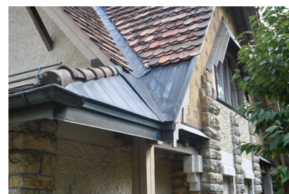
Photographie du détail de l'angle Ouest de la toiture aujourd'hui
