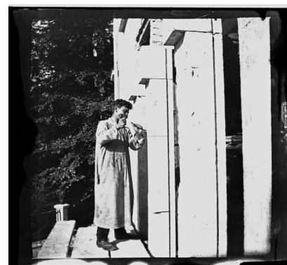
Photographie de Ch.E. Jeanneret travaillant l'appareil des pierres de la façade (BdV, LC108.0127.bis)
