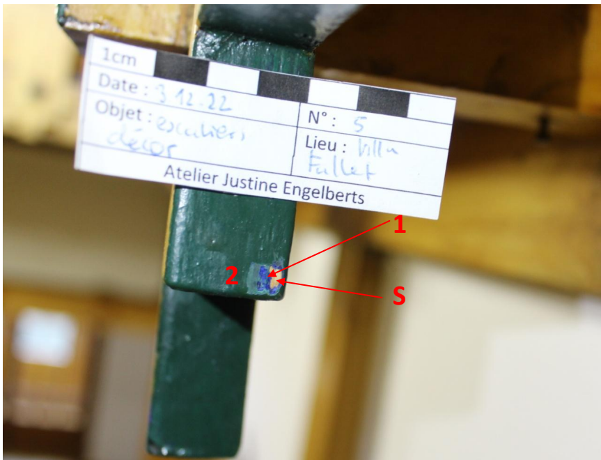
Sondage stratigraphique des décors peints du hall d'escalier (Engelberts, 2022, sondage n°5)
