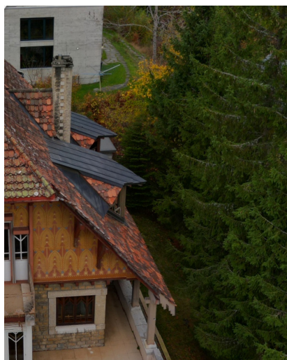
Photographie du détail de la cheminée, 2022 (extrait de la vue aérienne de l'entreprise ARCHEOTECH)
