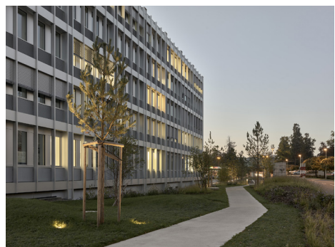
Figure 27_ Les abords du bâtiment ont aussi été sujet à réflexion avec la création d'espaces verts notamment, ©Francesco Ragusa
