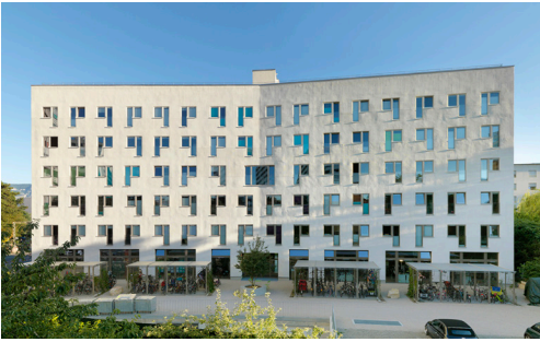
Figure 31_Façade Nord du bâtiment, ©atba architectes.
