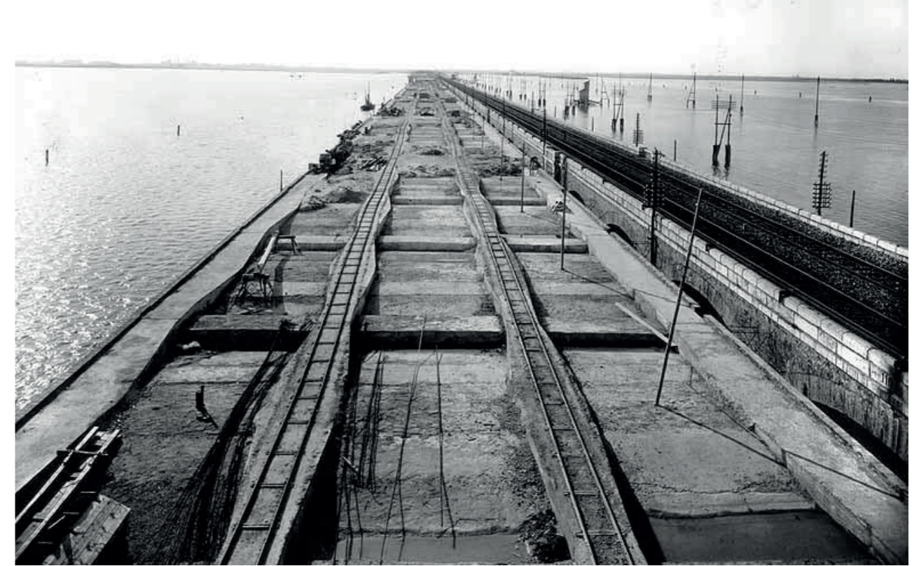
Photo historique de la construction du Ponte della Libertà, tirée de https://evenice.it/venezia/monumenti-chiese/ponte-della-liberta-venezia
