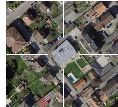
Fig. 10 : Vue satellite du Foyer Petitmaître
