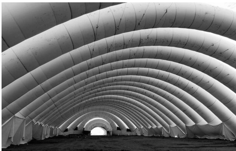
La tente mobile permettant de réaliser l'extraction des sols sans nuisance olfactive, 2022. © Florence Jaroniak
