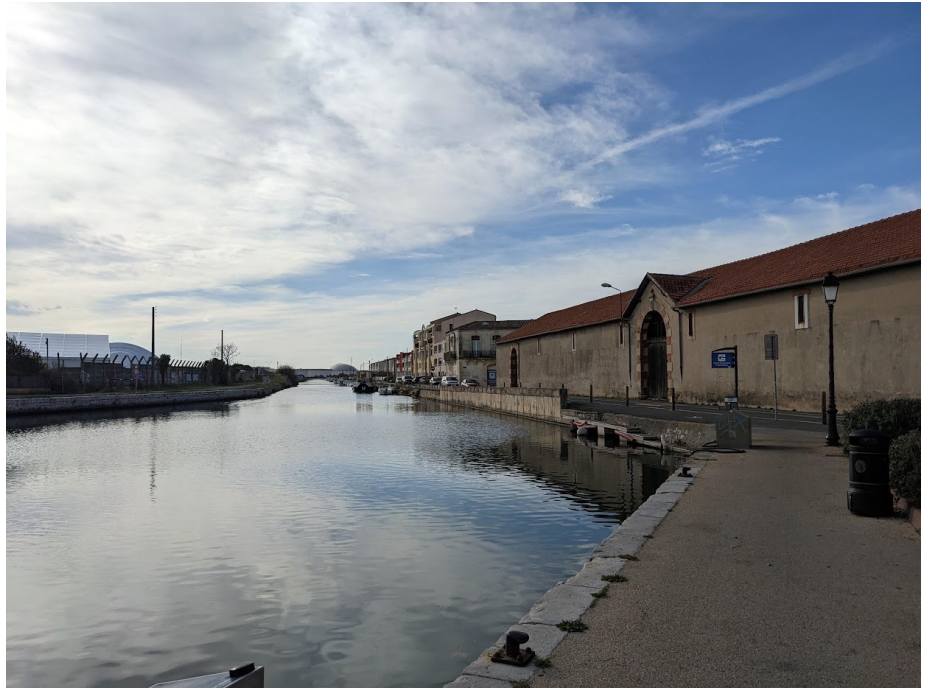
A droite un ancien bâtiment industriel, à gauche les tentes servant à la dépollution du site. Photo personnelle
