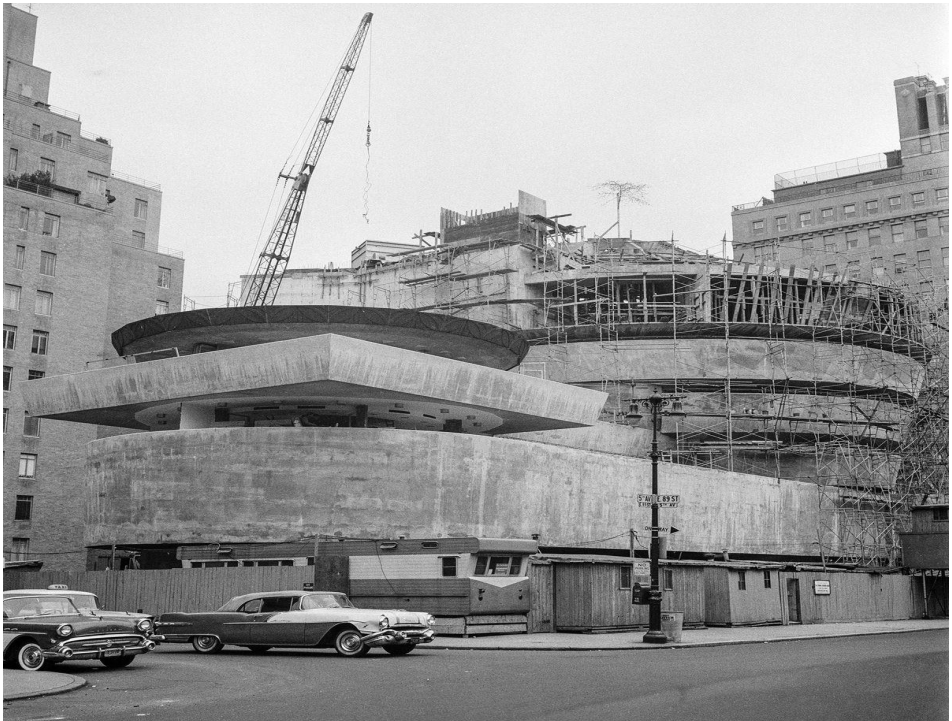
43. Frank Lloyd Wright, Guggenheim Museum en construction , New York, 1956-59
