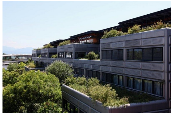
Figure 5.7: Photographie des terrasses végétales sur les plus vieux bâtiments du campus. ©Durabilité EPFL
