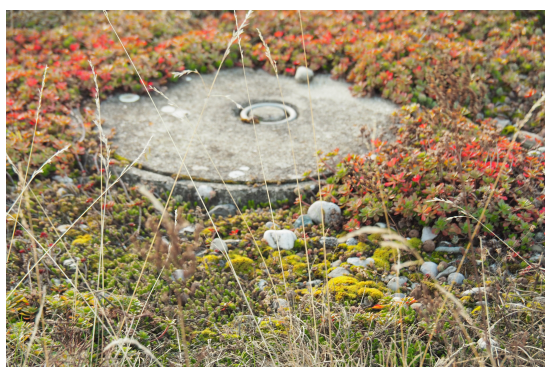
Figure 5.11: Photographie de l'épaisseur du substrat sur les toits de l'EPFL. ©Loé Maire
