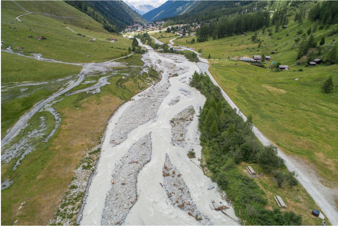
FIGURE 2.2 – Prise de vue aérienne de la Navisence après la crue de 2018. À droite, la rivière a fait son lit à la place d'une route. Source : LHE - Bob de Graffenried.
