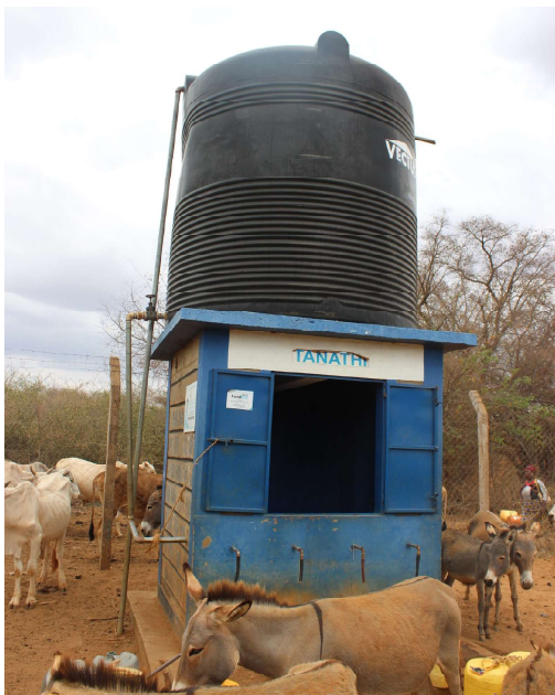
Figure 15: Water kiosk, Mumo wa Ikaaie.
