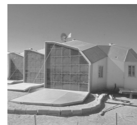
Photographies des grands volets de la Maison Baer, ©S. Baer.
