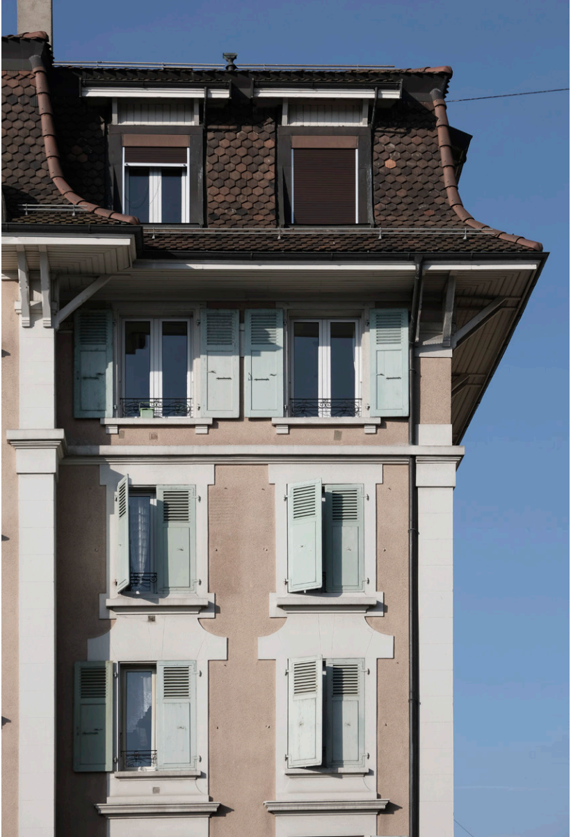
Avenue de Morges 41, façade lausannoise.
