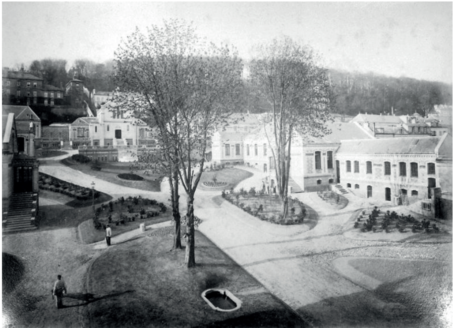
Fig. 22. La vue extérieure du nouvel hôpital du Havre proposé par M. Léon David, construit en 1885. Les patients avaient un contact direct avec la nature.
