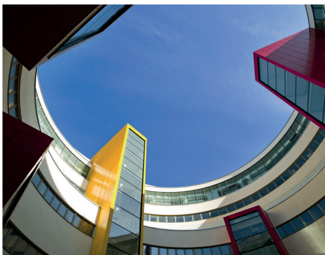
Fig. 43. Vue depuis la cour du Centre hospitalier universitaire de Malmö. La forme circulaire est conçue en fonction des exigences logistiques des soins infectieux.
