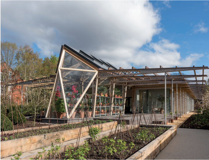
Fig. 79. Le Maggie's Center de Manchester, réalisé par le bureau Foster + Partners, rappelle une serre – une célébration de la lumière et de la nature – qui offre un jardin de retraite et un espace de rassemblement. Le toit du Maggie's Center s'élève au centre pour créer un niveau de mezzanine, éclairé naturellement par des lucarnes triangulaires et soutenu par des poutres légères en treillis de bois. Les poutres agissent comme des cloisons naturelles entre les différentes zones internes, dissolvant visuellement l'architecture dans les jardins environnants.
