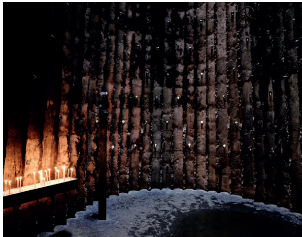
Fig. 68. La forme et la texture de l'intérieur sont créées par l'ossature de troncs d'arbres qui a été brûlée lentement pendant trois semaines après la mise en place du béton, ce qui laisse l'intérieur taché de charbon de bois, comme une impression négative de bûches qui offre le parfum brûlé du feu et des cendres dans l'espace.
