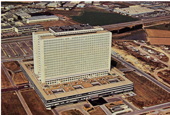
Fig. 26. Le CHU de Caen est un hôpital construit en 1975 par Henry Bernard. Une tour d'hospitalisation s'élève au milieu du soubassement.
