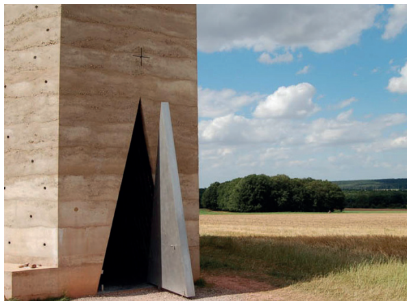
Fig. 64. Tout d'abord, la forme et l'épaisseur de la porte d'entrée en acier inoxydable de la chapelle est un triangle isocèle, une forme et une épaisseur non conventionnelles pivotées sur une seule charnière coulée dans le sol, créant une expérience visuelle à travers laquelle on peut remarquer la lourdeur de la porte avant de l'ouvrir.
