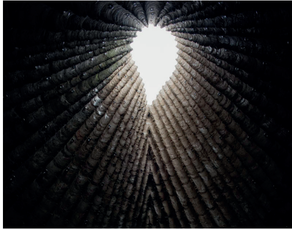
Fig. 67. L'espace intérieur a un vide (oculus) qui s'ouvre au sommet et qui est la source centrale de la lumière et des petits bouts de lumières provenant des petits trous recouverts de verre soufflé à la main qui apparaissent comme des étoiles la nuit en utilisant une lumière et des matériaux faibles dans les intérieurs.
