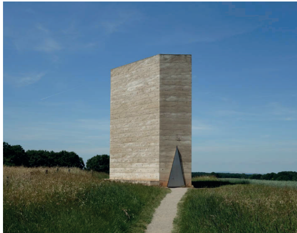
Fig. 63. Il s'agit d'un solide bâtiment pentagonal de forme irrégulière, haut de 12 m et fait de béton, situé au milieu des champs entourés de forêts. L'activation des sens, la matérialité, la qualité des détails et la création d'une atmosphère dans l'espace sont les points forts de ce projet.
