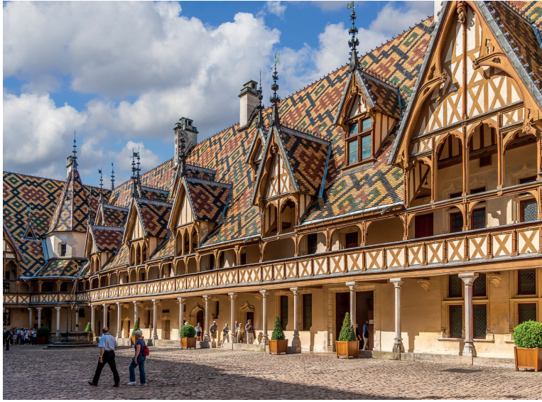
Fig. 8. Les Hospices de Beaune forment un ensemble pittoresque de structures centrées autour d'un espace central imposant. Ses flèches polychromes font de l'édifice un point de repère, un élément pivot du paysage.
