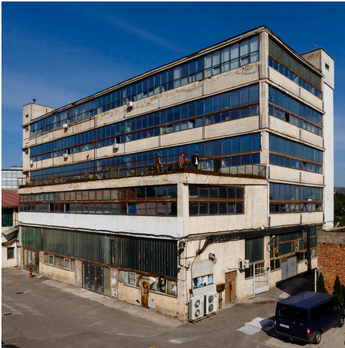
fig 38. Fabrique à pinceaux, Cluj-Napoca, Roumanie, 2021
