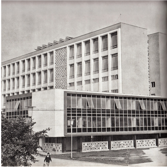
fig 4. Usine de vêtements, Focșani, Roumanie, 1967
