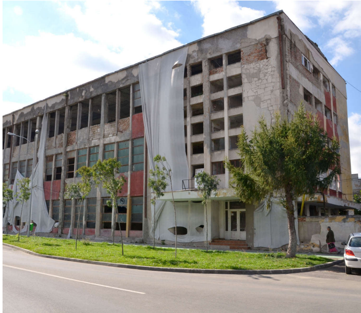
fig 34. Fabrique de chocolat Kandia, Timișoara, Roumanie, 2014
