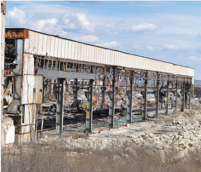
fig 35. Usine 1 Mai, Ploiești, Roumanie, 2021
