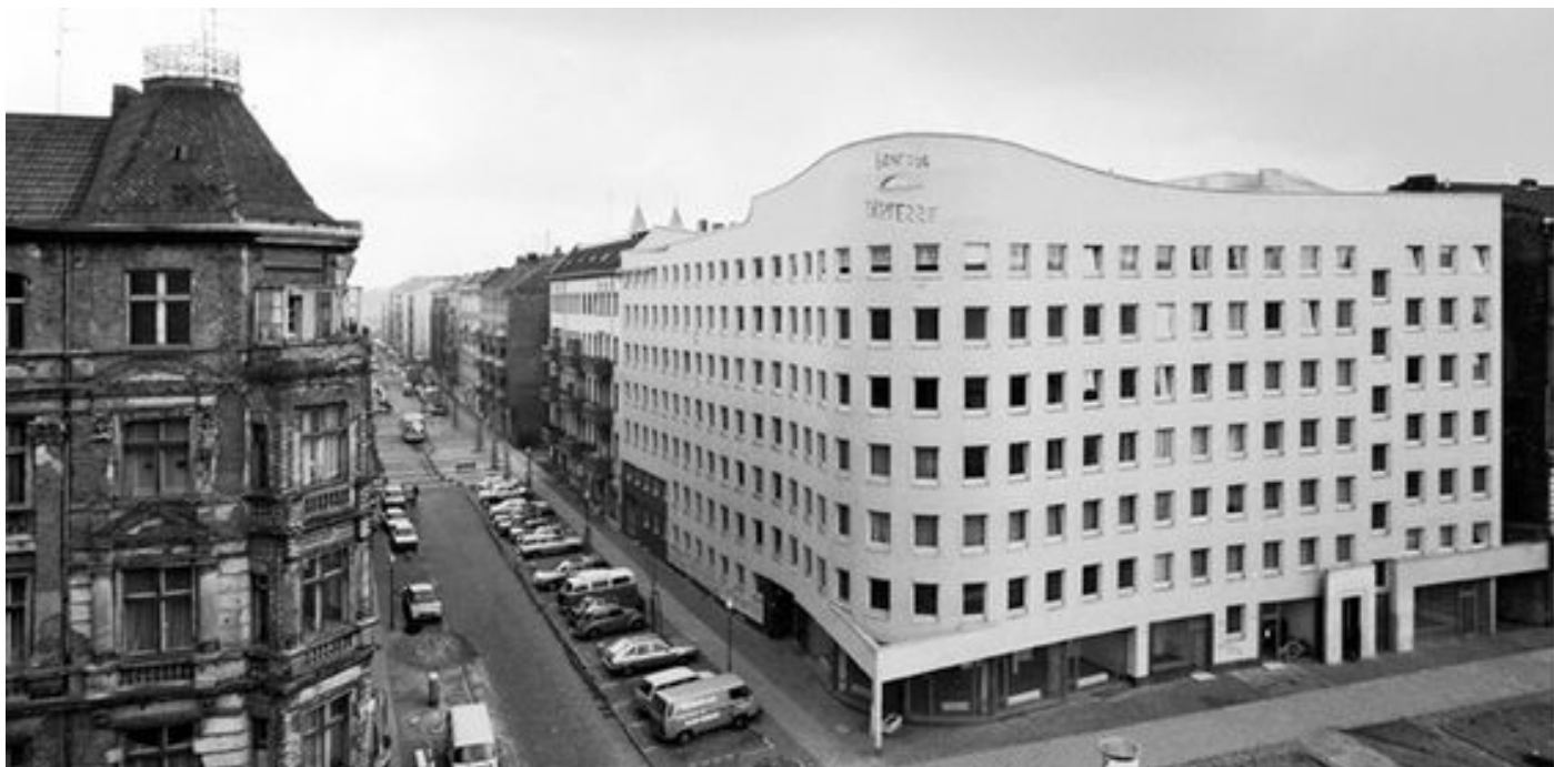
(22) Vue du Bloc 121 à Schlesische Strasse 1990, Source : The Mart Photo Archive and Media Library ©
