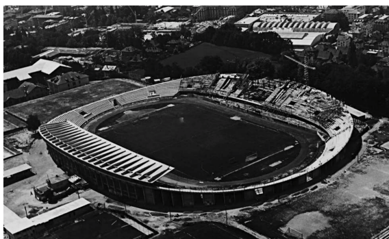
Chantier, troisième étape, bétonnage des gradins de la tribune sud en mai 1953 © Giulia Marino fig. 47
