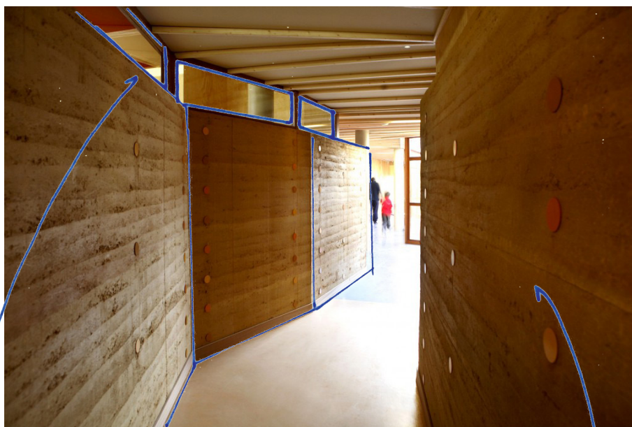
UN COULOIR IRRÉGULIER CENTRE D'ACCUEIL DE JOUR KIËTHON ASA Gimbert architectes Médélec, France 2008
