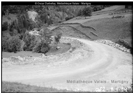
HAUT Routes pour le chantier du barrage de Moiry, Val d'Anniviers, 1954.
