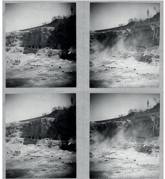
Figure 9. Photographies successives d'une explosion dans les carrières de gypse d'Argenteuil en 1885
