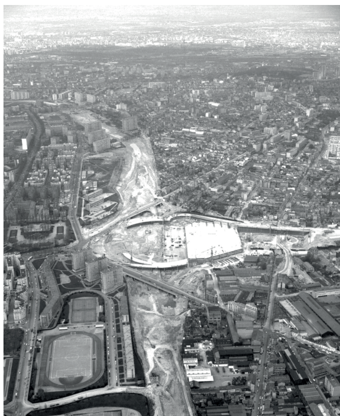
Figure 23. L'immense chantier de l'échangeur de Bagnolet en 1969 Photographie aérienne. APUR, Archive des ponts et chaussées
