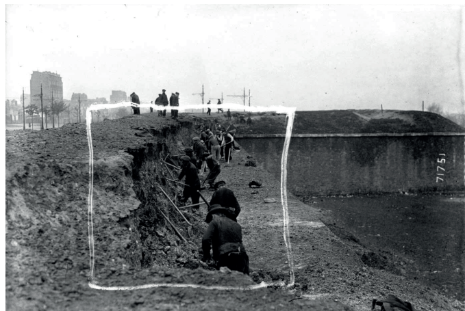
Figure 18. Destruction de l'enceinte de Thiers à la porte de Clignancourt Plan : Archives Bibliothèque Nationale de France
