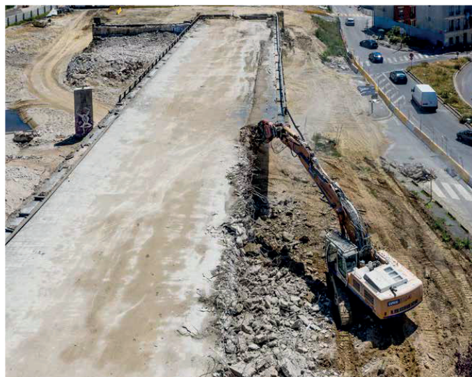
Figure 28. Démolition de l'autoroute A186 pour le prolongement du tramway à Romainville
