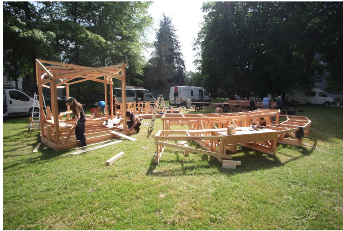
figure 2, chantier de l'agora
