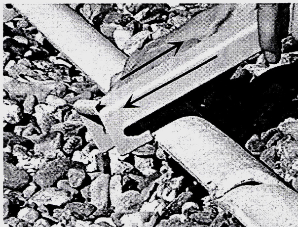
h). Placer les crochets en contraignant le SolBac.
