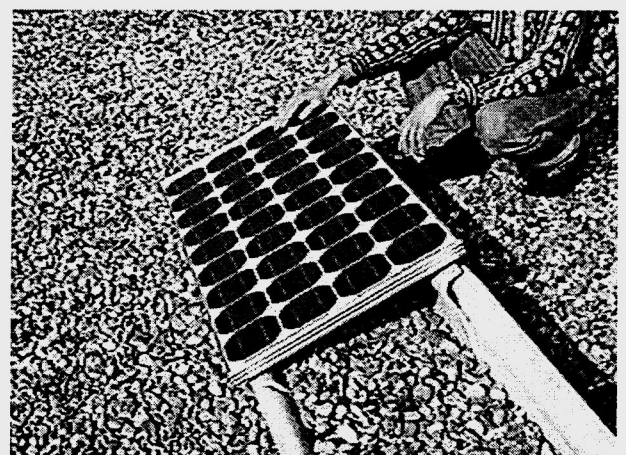
l) Le module est ainsi solidement fixé.
