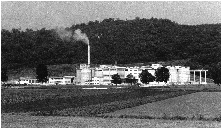
[Fig.4] Construction de la cimenterie d'Eclépens, 1953
