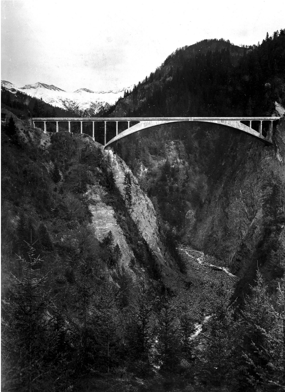
[Fig.3] Pont de Salginatobel construit par Robert Maillart, 1930.
