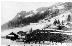
fig.17 scierie des Planches ANEX Paul, 1994. La Vallée des Ormonts ; Ormonts-Dessus, Ormonts-Dessous. Lutry, H.-L. Guignard. p.225
