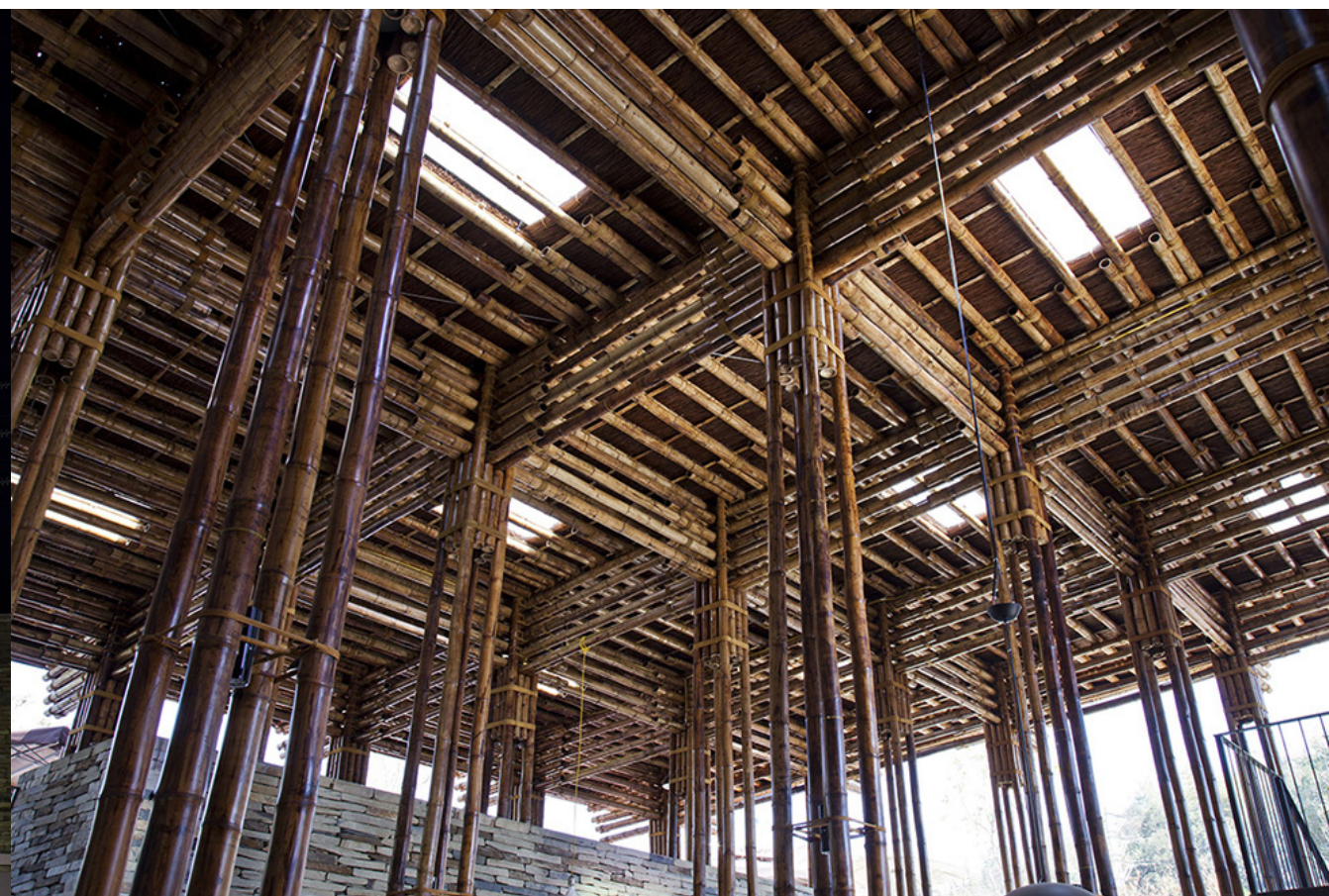
fig. 43 | vue de la charpente de la toiture
