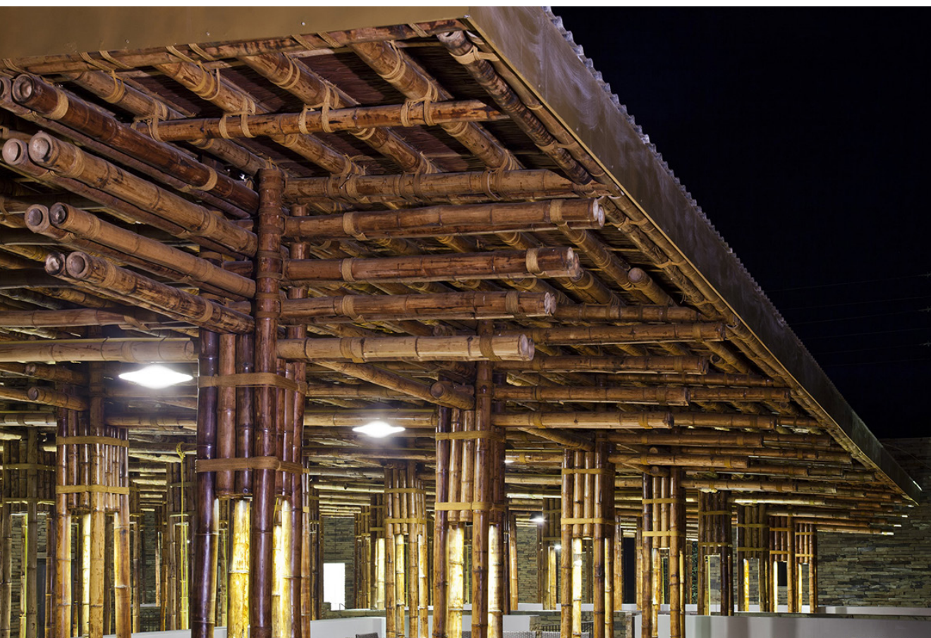
fig. 42 | détail de la toiture
