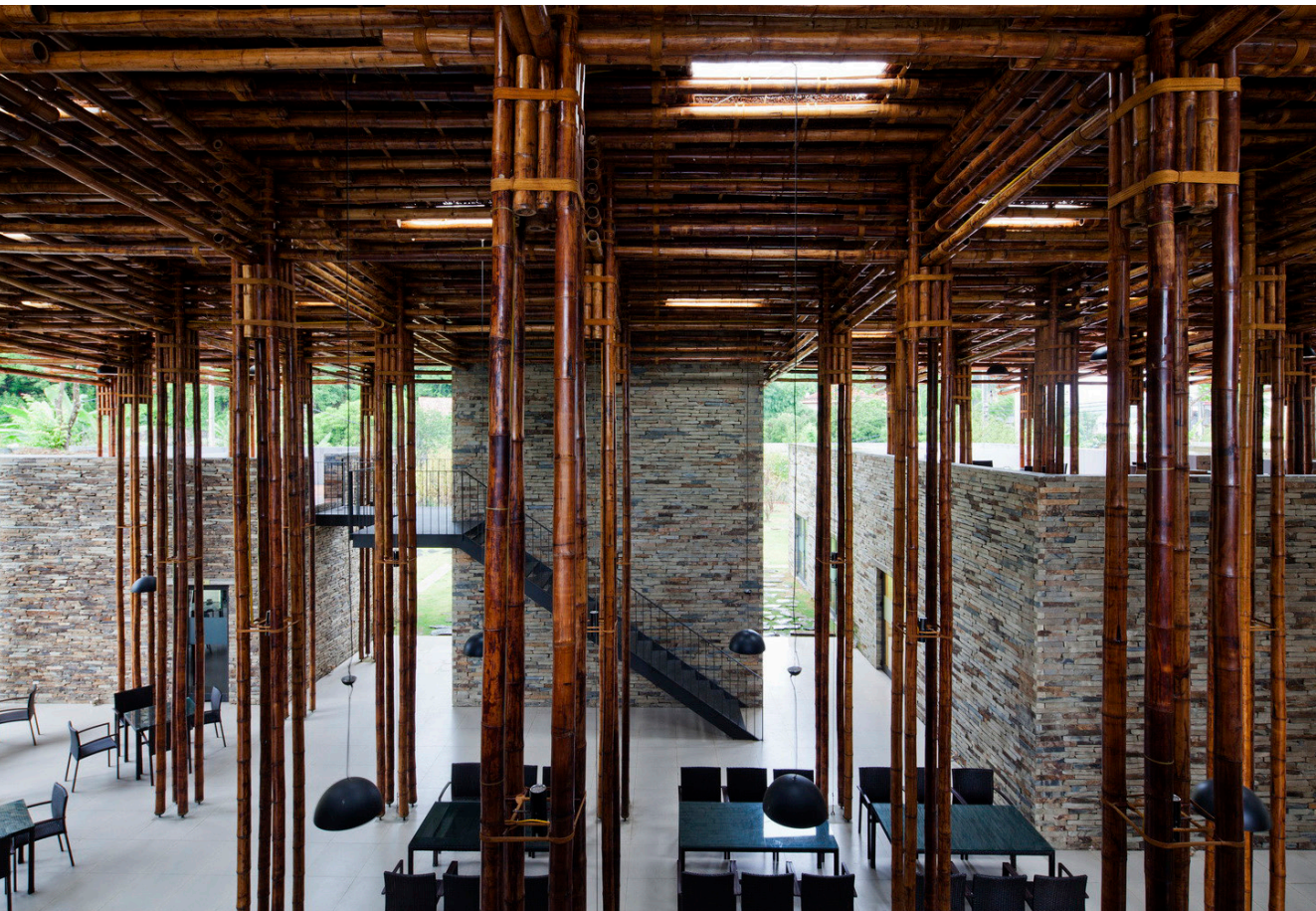
fig. 53 | structure poteau-poutre du Son La Restaurant, par VTN Architects
