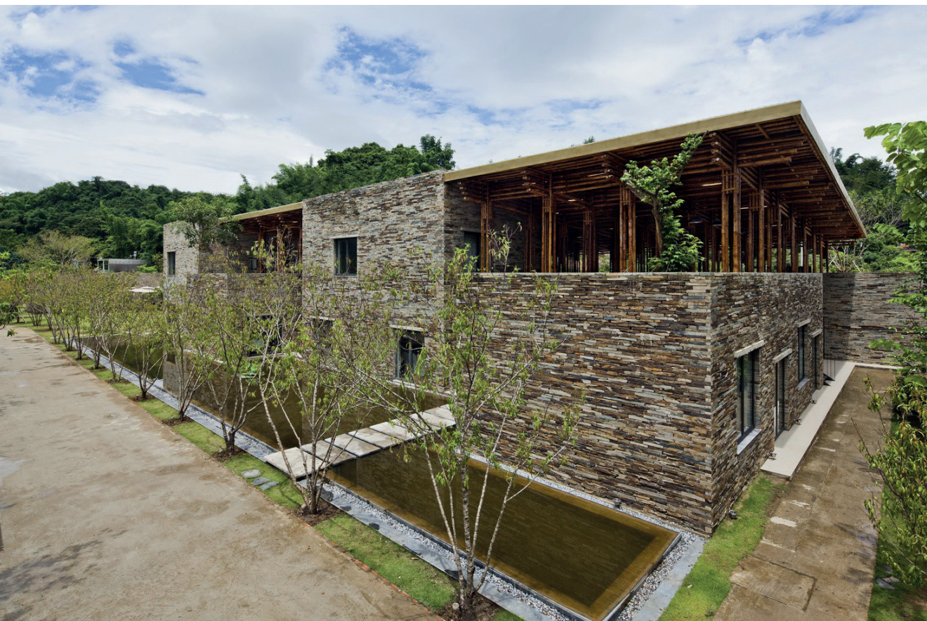
↓ fig. 36 | vue générale du Son La Restaurant
