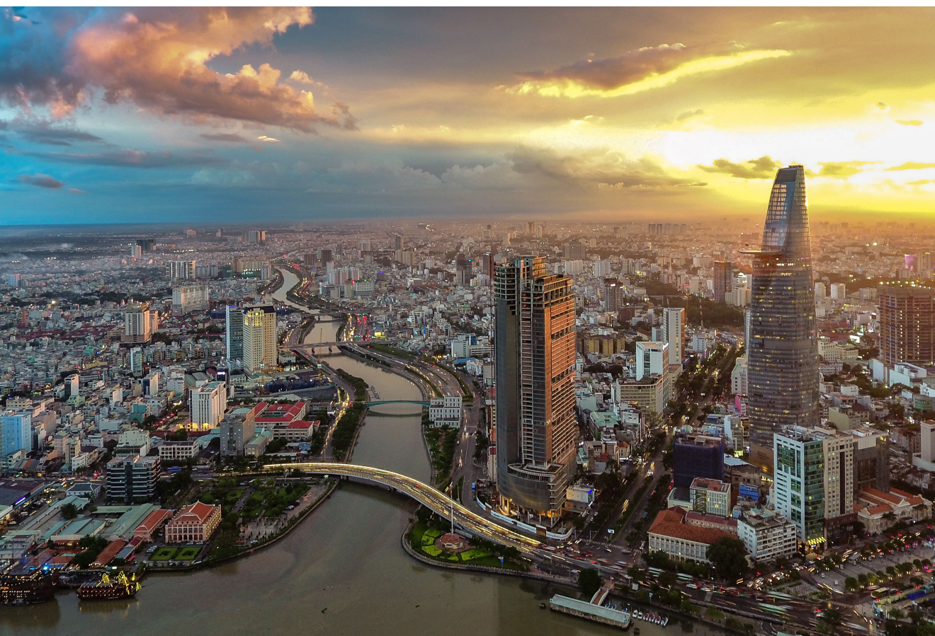
↓ fig. 9 | vue aérienne de Hô Chi Minh-Ville
