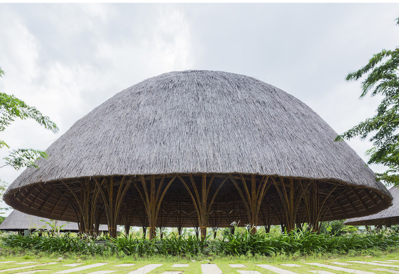
fig. 25 | vue du grand dôme avec sa couverture
