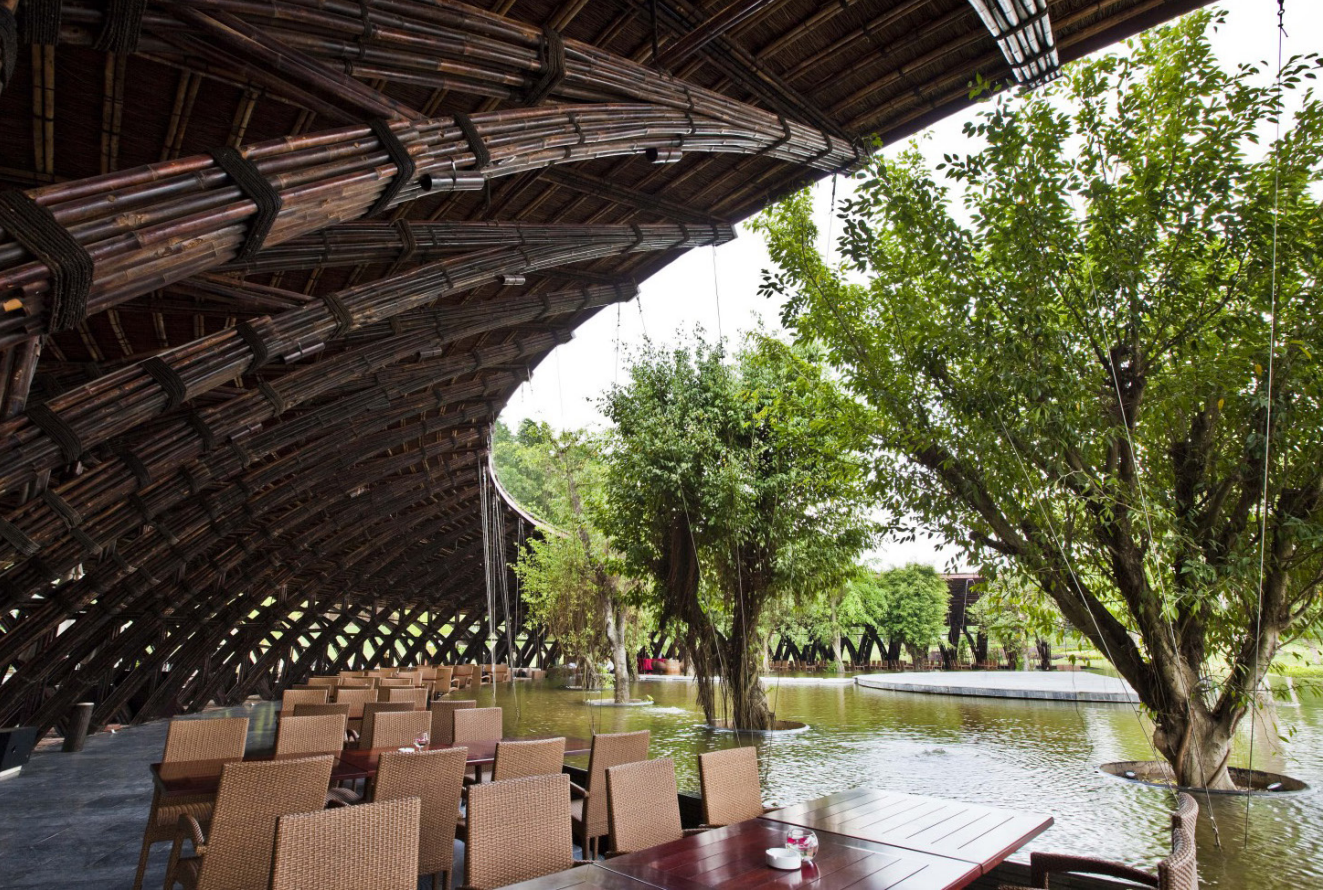
↑ fig. 44 | porte-à-faux du Bamboo Wing, par VTN Architects
