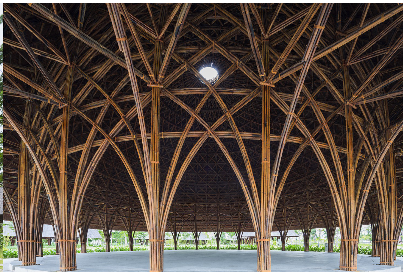
fig. 26 | vue de la charpente du dôme
