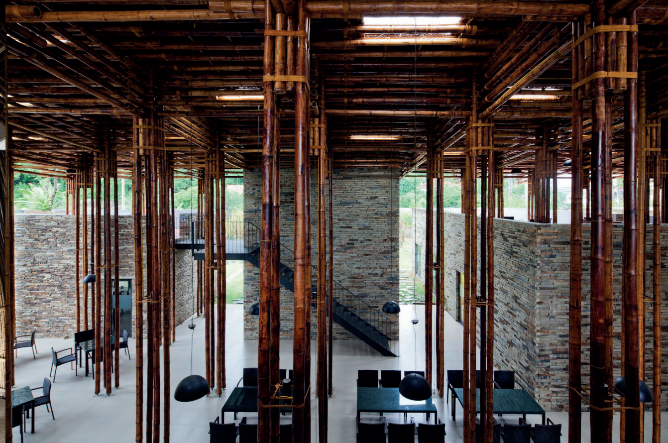
↑ fig. 50 | structure poteau-poutre du Son La Restaurant, par VTN Architects ↓ fig. 51 | expression de l'ossature poteau-poutre en béton, par Auguste Perret
