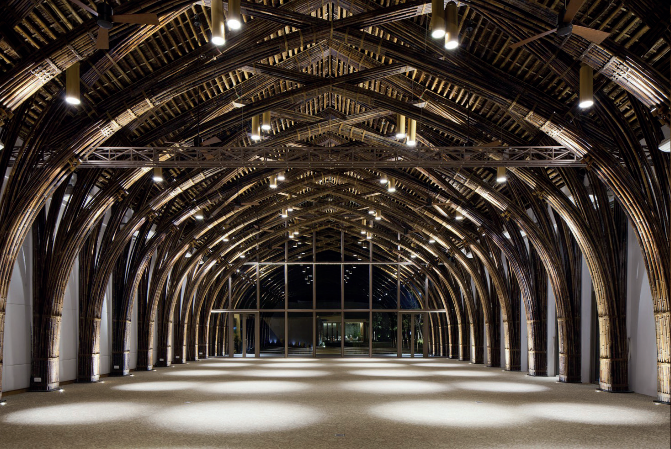
↑ fig. 48 | succession de cadres du Naman Conference Hall, par VTN Architects ↓ fig. 49 | structure nervurée de la nef de la cathédrale d'Ely
