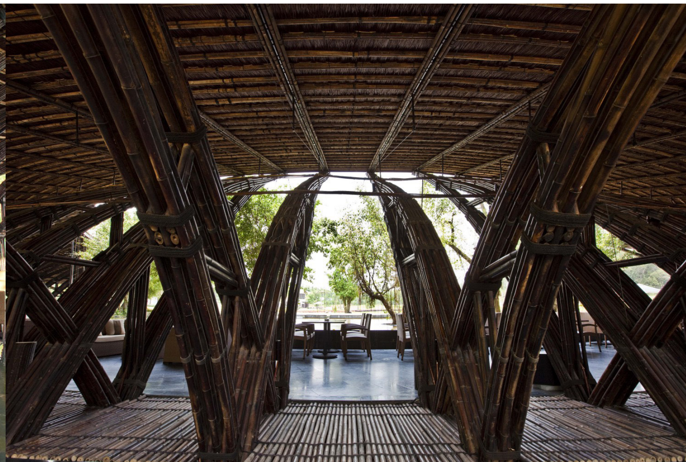
fig. 17 | déploiement de la structure
