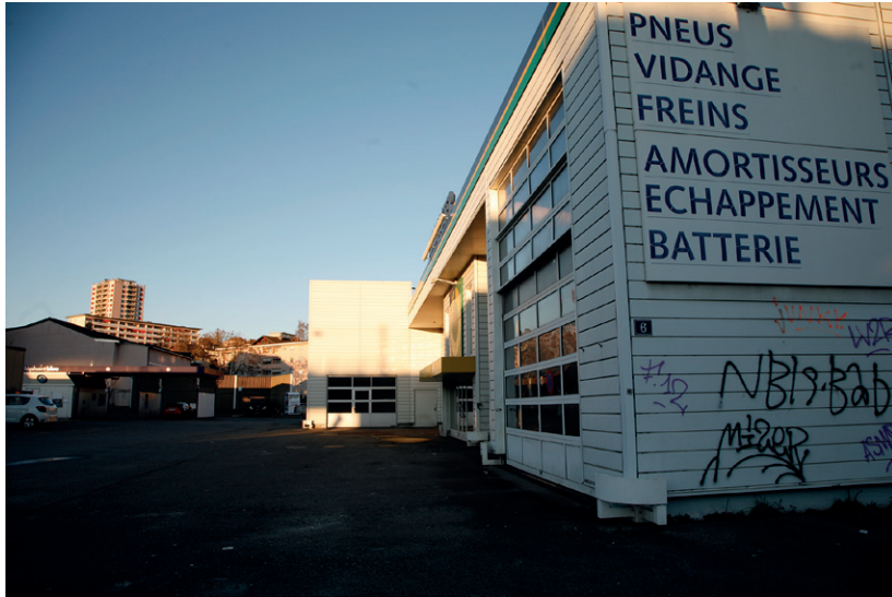
fig. 62 : photographie du site, Prilly
