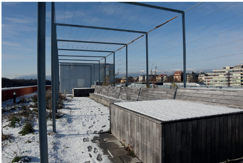
fig. 21 : photographie de la toiture, Jonction
