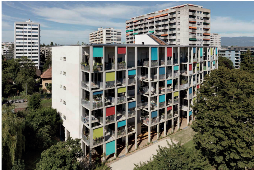
fig. 26 : photographie du bâtiment, Soubeyran Coopérative Equilibre
