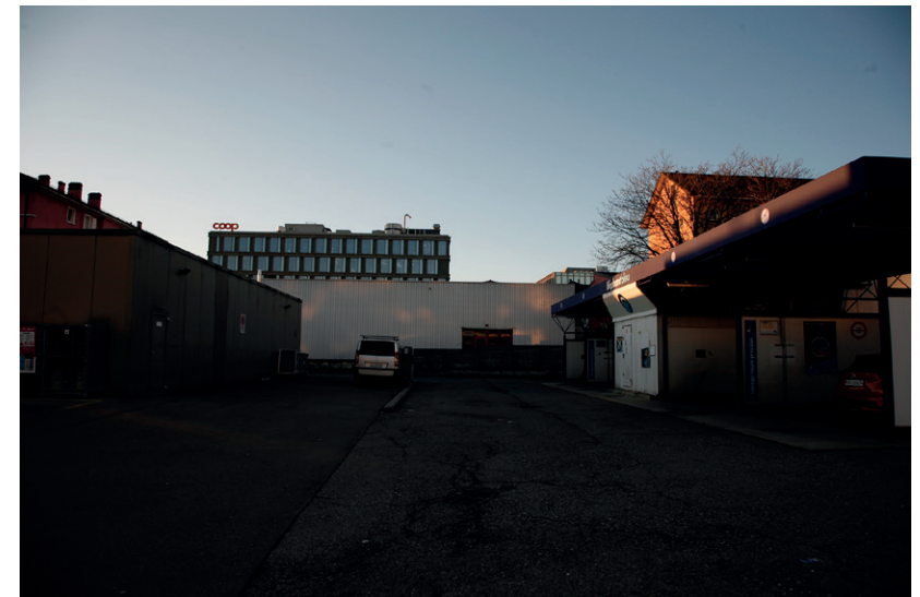
fig. 65 : photographie du site, Prilly
