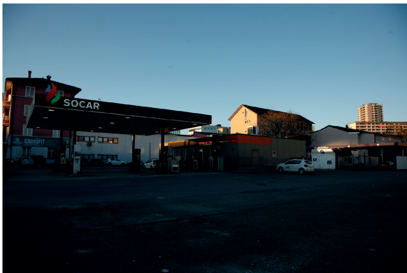
fig. 61 : photographie du site, Prilly
