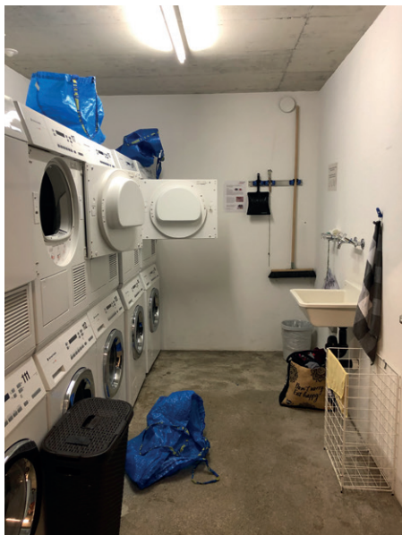
fig. 49 : photographie de la buanderie, Zwicky-Süd
