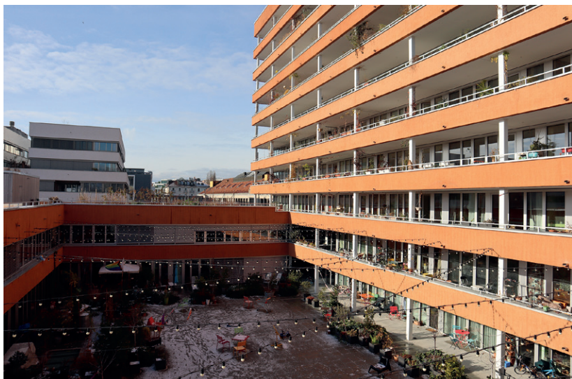
fig. 9 : photographie de la cour, Jonction
