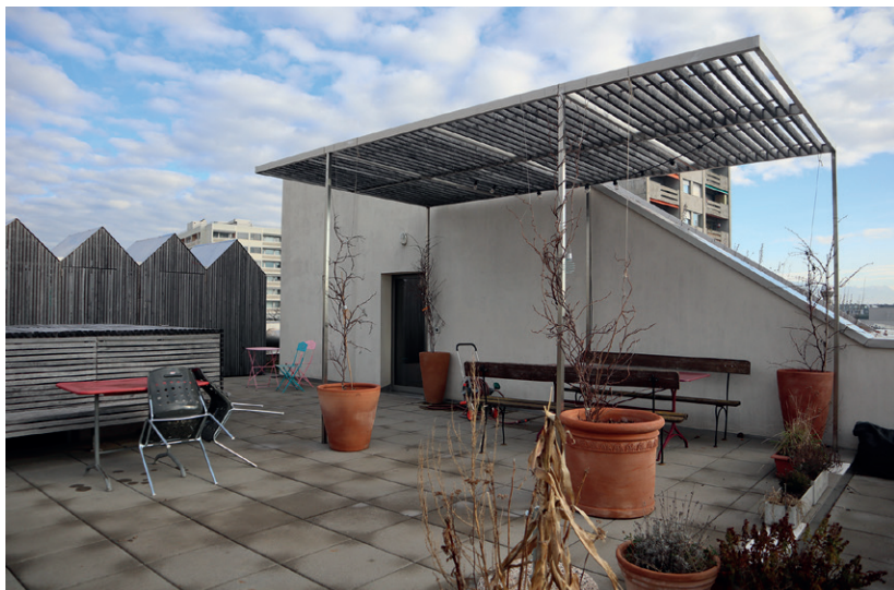
fig. 37 : photographie de la toiture-terrasse, Soubeyran
