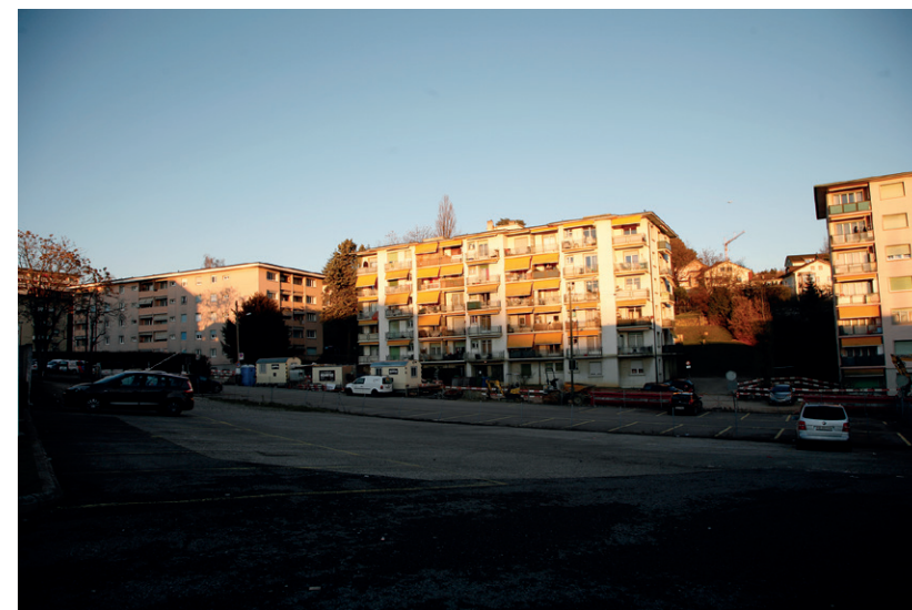
fig. 59 : photographie du site, Prilly
