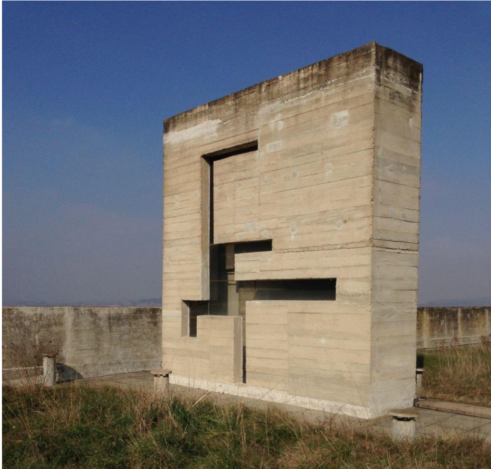
Fig. 97 : Le Neume de la toiture du Couvent de la Tourette
