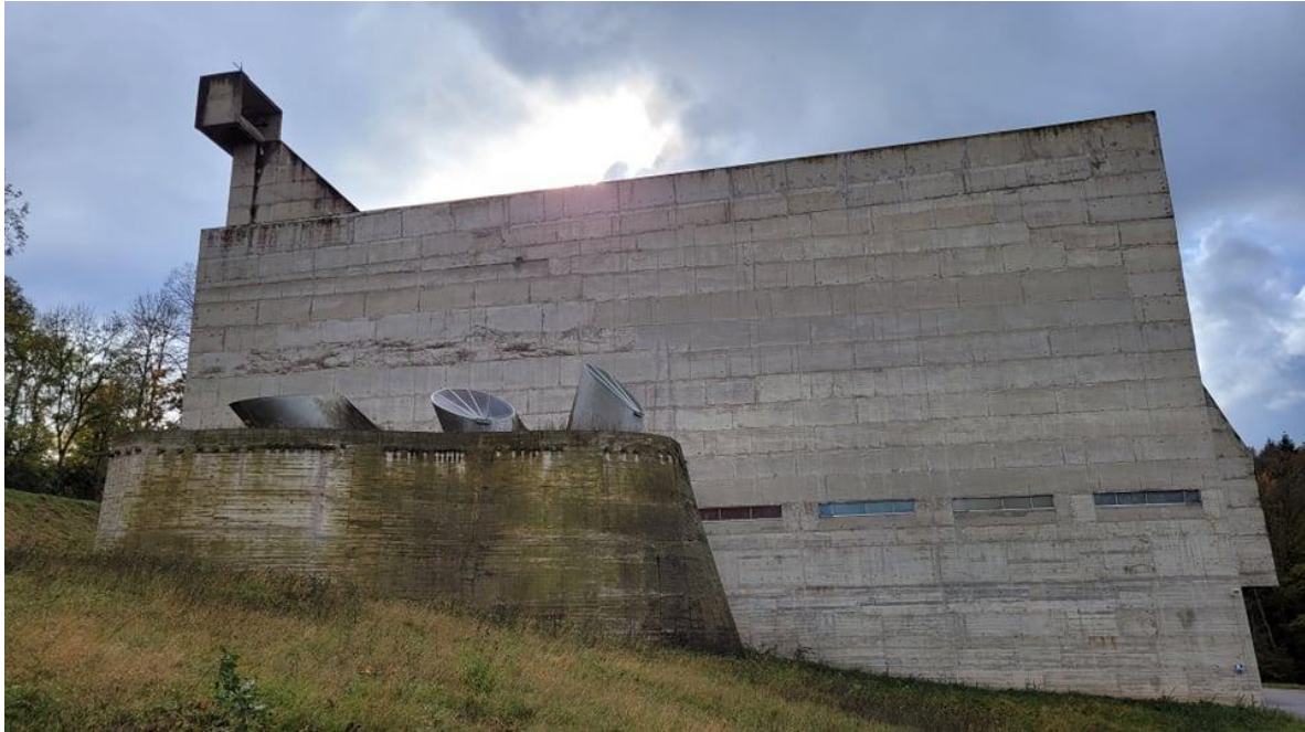
Fig. 45 : Vue de la façade sud de l'église
