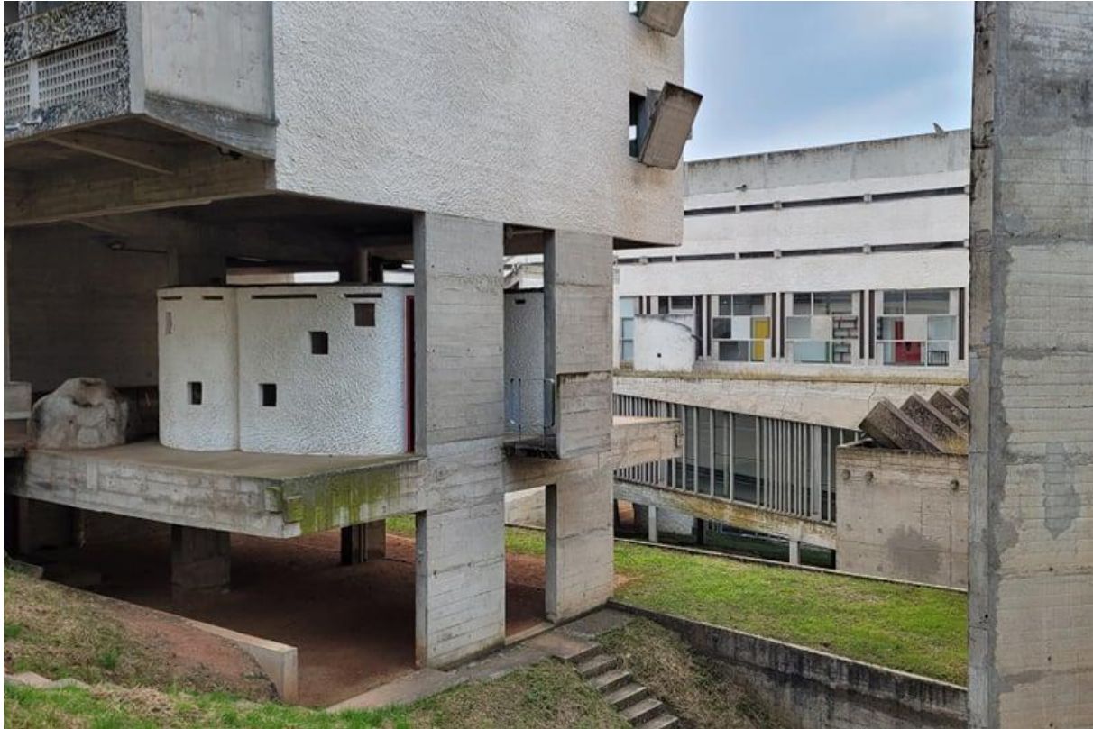
Fig. 46 : Ouverture sur l'intérieur du couvent
