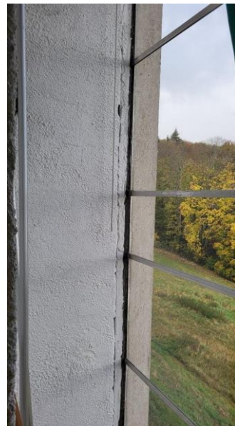
Fig. 82 : Isolation phonique en mousse sur la façade Ouest
