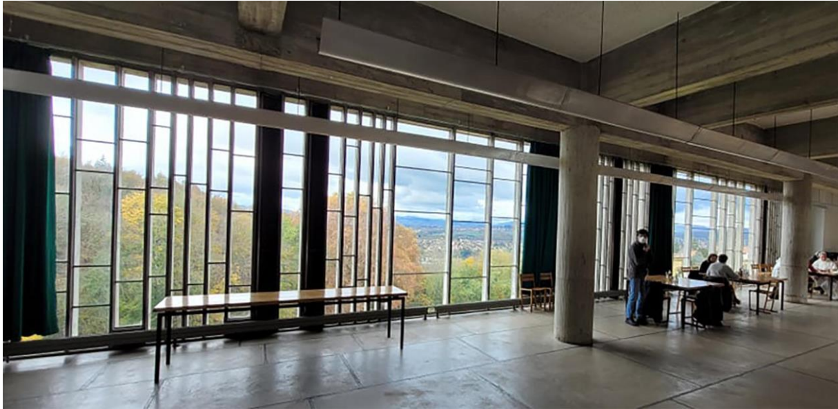
Fig. 92 : Vue du réfectoire avec la dilatation des pans dans l'axe des piliers cannelés
