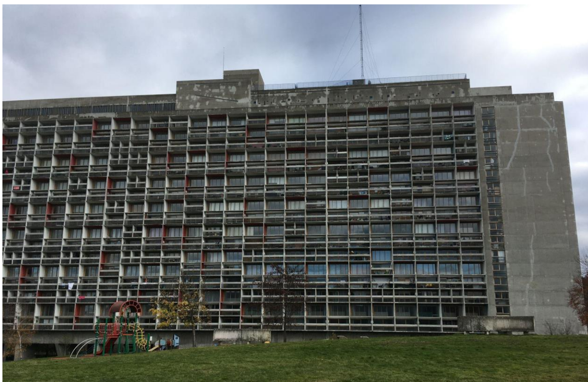
Fig. 106 : Façade Ouest de l'Unité d'Habitation de Firminy-Vert, 2021
