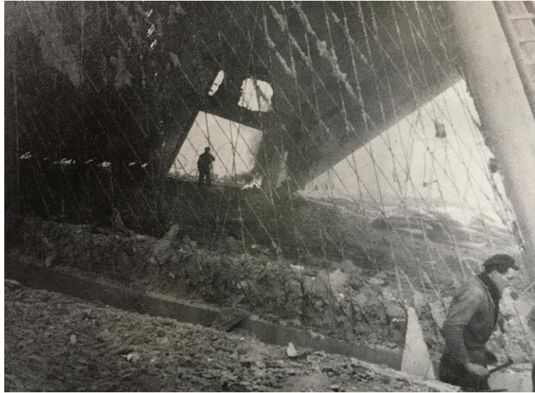
Fig. 137 : Démolition du Pavillon Philips, 1959. On voit encore les câbles servant de définitions aux surfaces réglées. (©FLC-Prolitteris)
