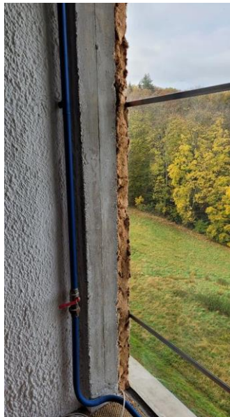
Fig. 82 : Isolation phonique en mousse sur la façade Ouest
