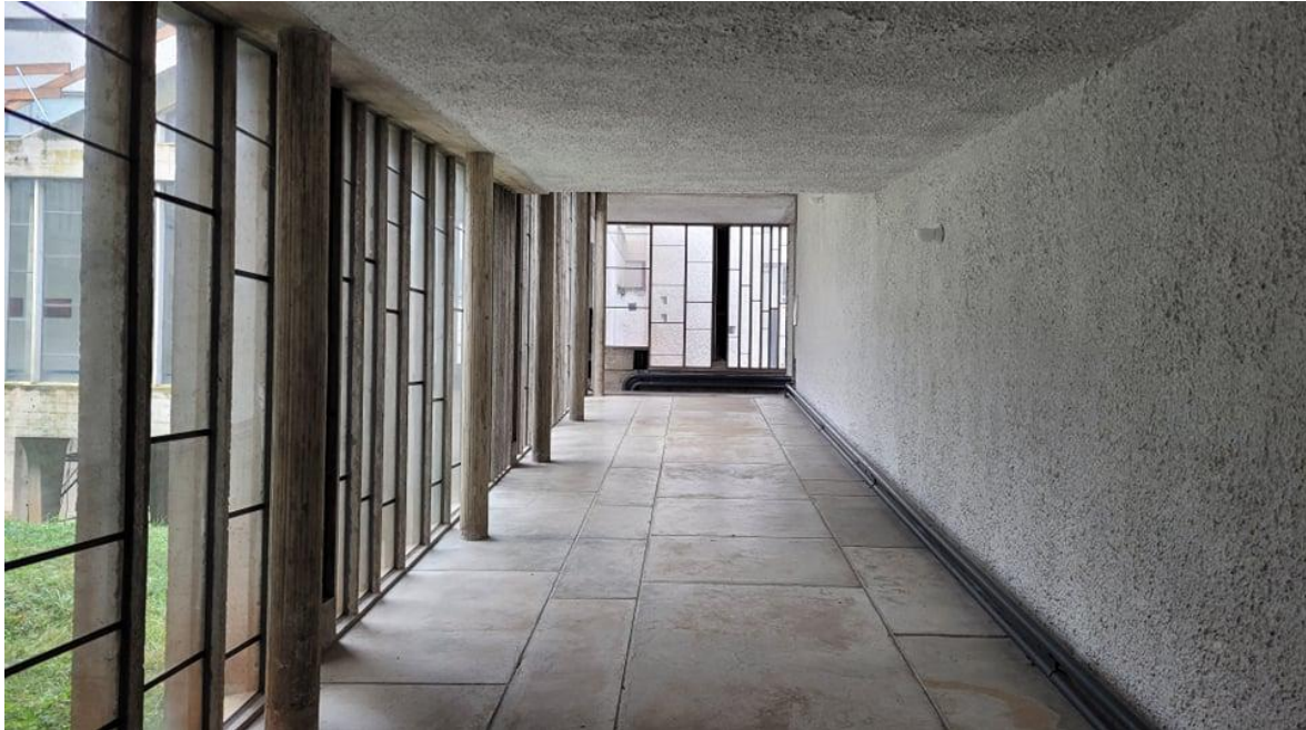
Fig. 75 : Vue du pan de verre ondulatoire en face du petit conduit
