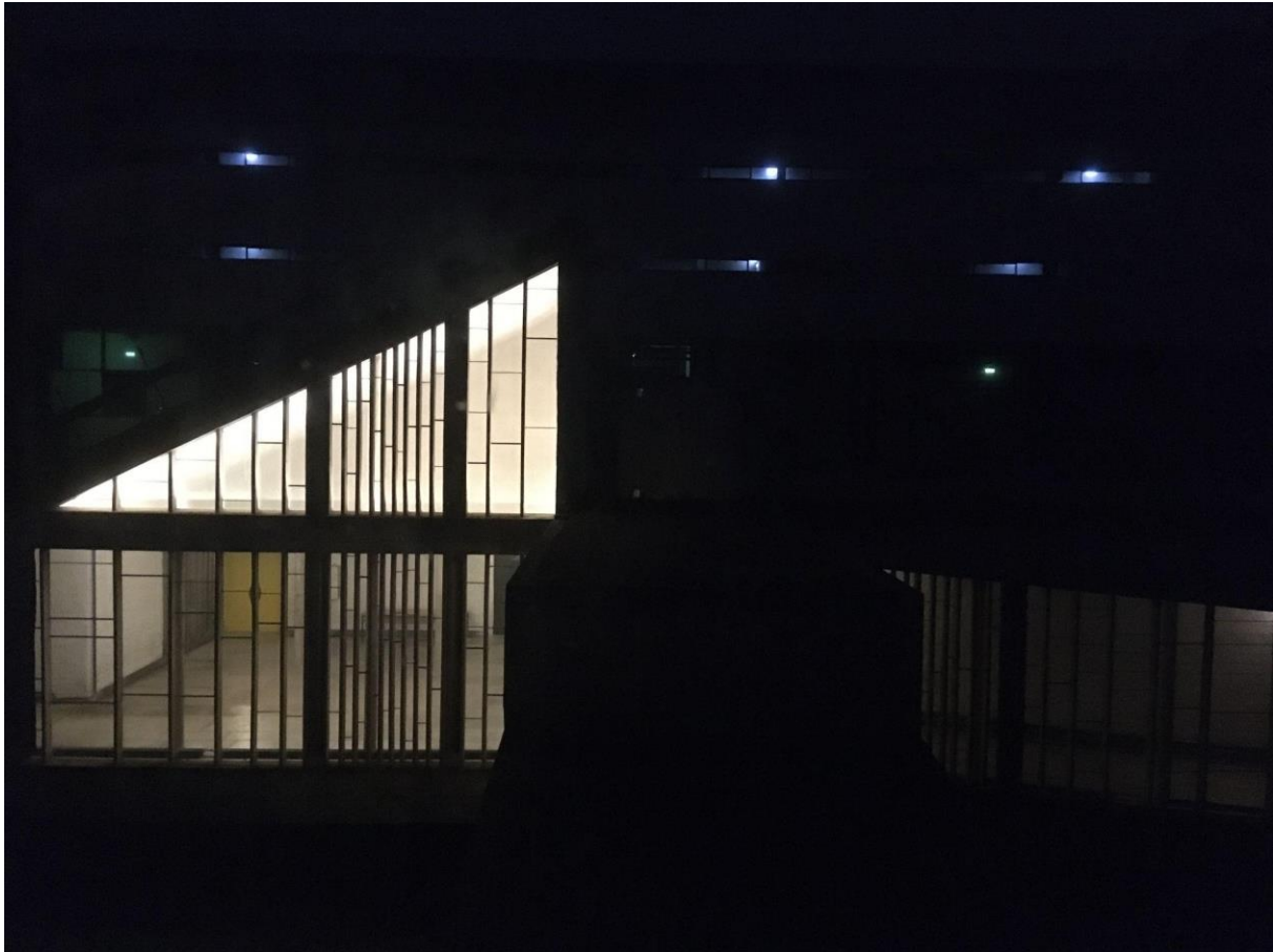
Fig. 80 : Vue du triangle de l'atrium avec les potelets superposés
