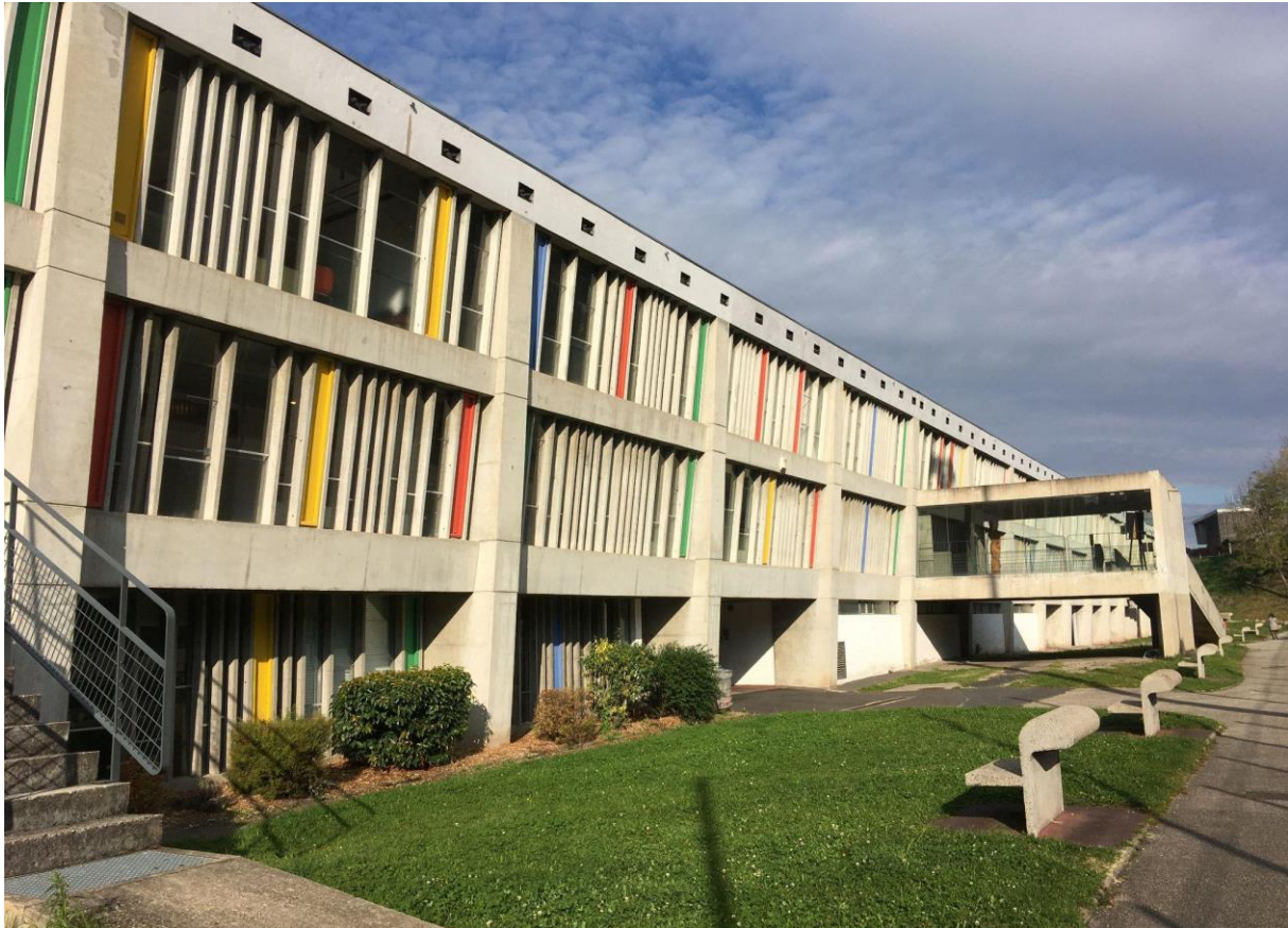
Fig. 110 : Façade Est de la Maison de la Culture de Firminy, pans de verre ondulatoires de Xenakis
