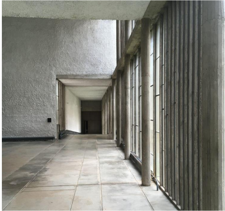
Fig. 65 : Vue des pans de verre ondulatoires du grand conduit. La rugosité des pans est accentuée par la lumière pénétrante
