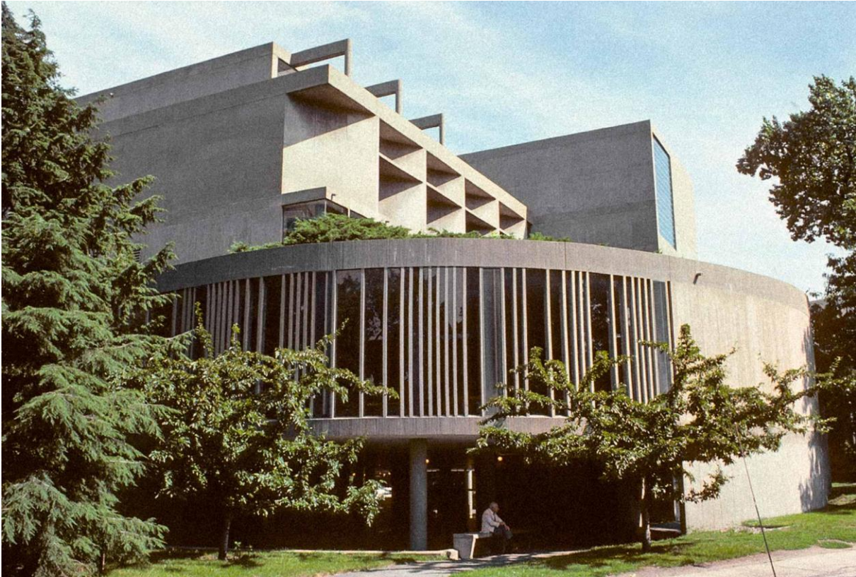
Fig. 122 : Pans de verre ondulatoires du Carpenter Center de Harvard
