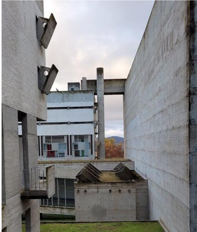
Fig. 47 : Ouverture sur l'intérieur du couvent
