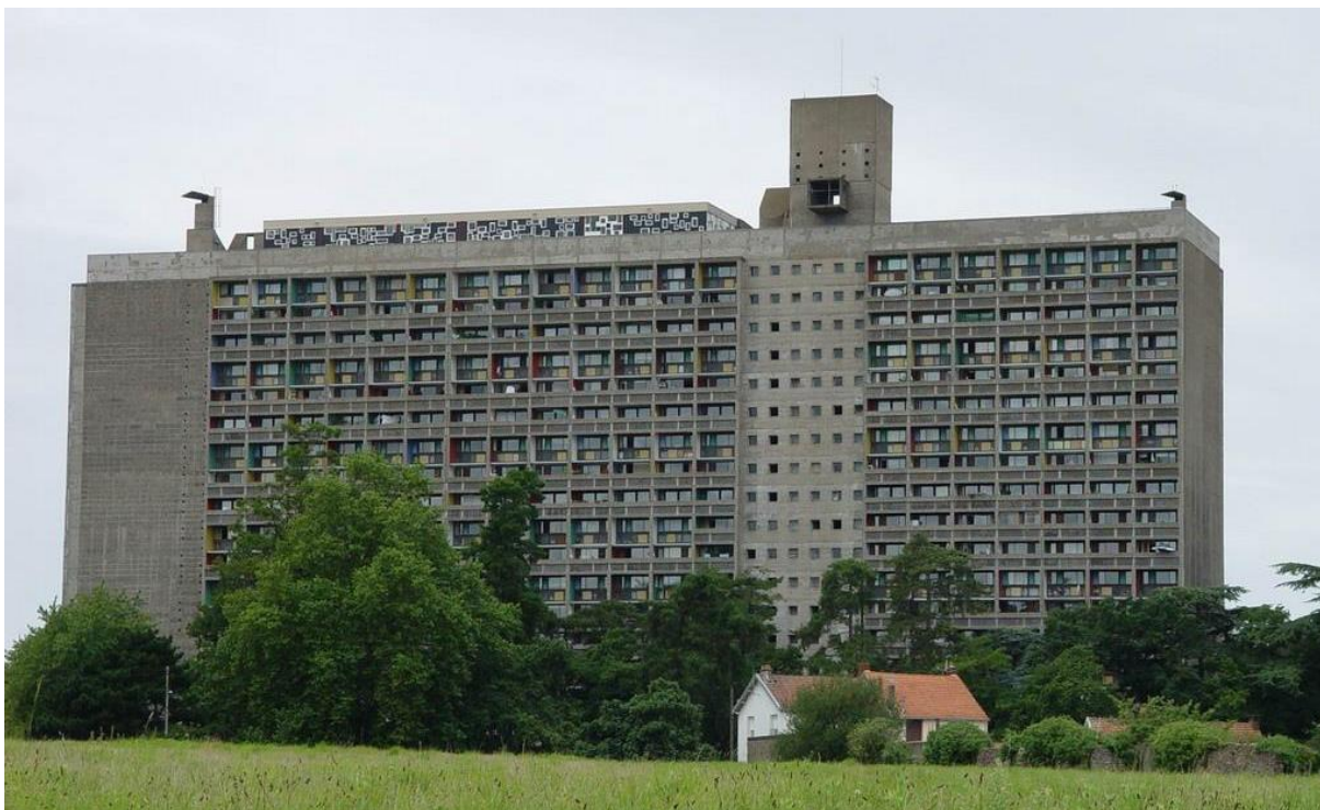
Fig. 100 : Vue générale de la Cité d'Habitation de Rezé-Lès-Nantes. Les Neumes de la garderie se déploient le long des parois de cette dernière
