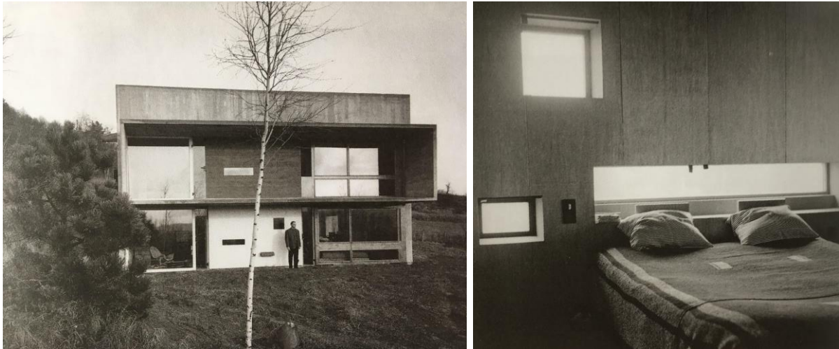
Fig. 130 : Photographie de la façade Ouest
