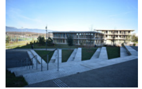
Fig 81: 1 Gradin à côté de l'école des Vergers.
