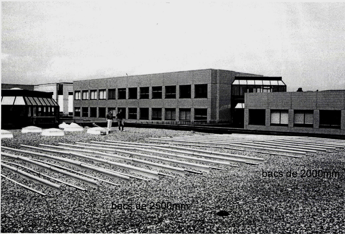
Fig. 3 : Situation des deux champs en cours de montage
