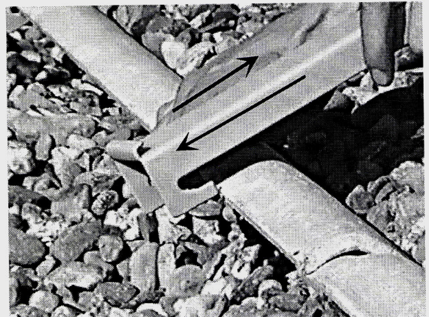
2. Placer les crochets en contraignant le SolBac.
