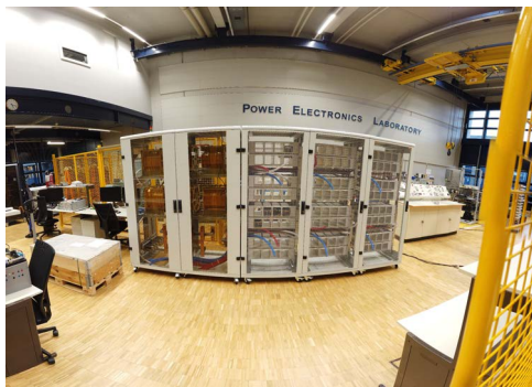
▲ MMC - Actual mechanical assembly
